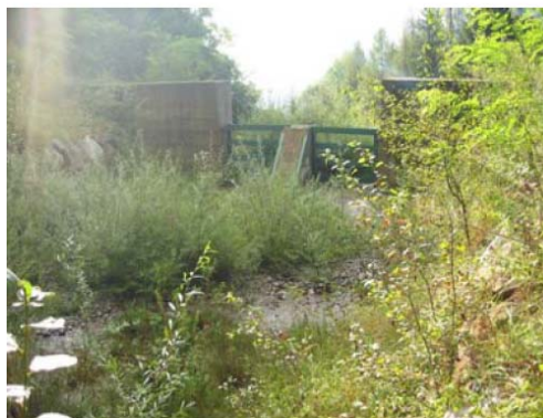
Opere di regimazione idraulica trasversali (briglie) lungo il torrente
