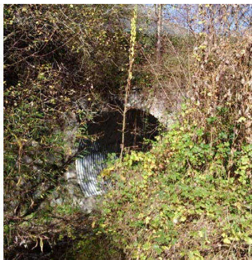
Tombinamento: vista dell'entrata a monte della strada provinciale e uscita in prossimità del T. Trobiolo
