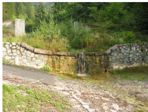
Opere di regimazione idraulica trasversali (briglie) lungo il torrente
