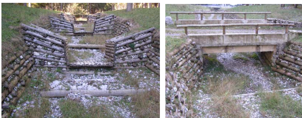
Opere di regimazione idraulica trasversali (briglie in legname e pietrame) lungo il torrente
