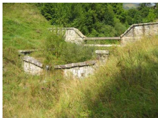
Opere di regimazione idraulica trasversali (briglie) lungo il torrente
