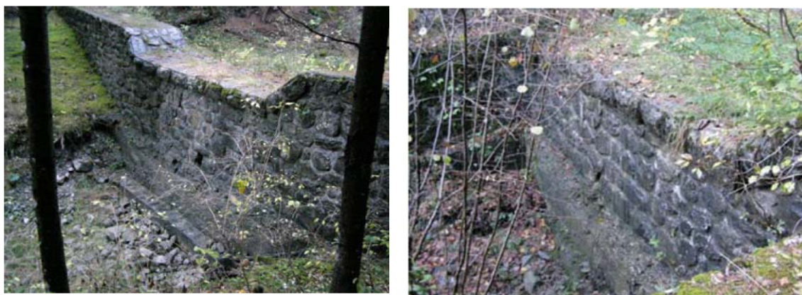
Opere di regimazione idraulica trasversali (briglie in pietrame e cls) lungo il torrente
