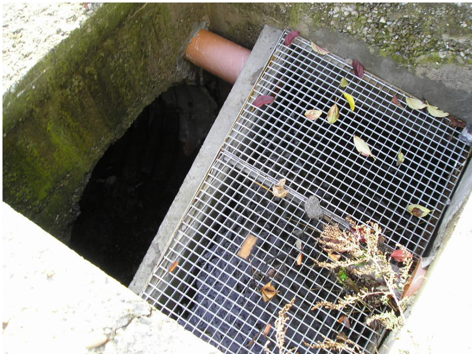
Foto 4: sezione 2, tombotto di Via Dante. Al di sotto del tubo uscente dalla vasca c'è il condotto circolare di 1.40m usato come sezione nelle verifiche idrauliche speditive
