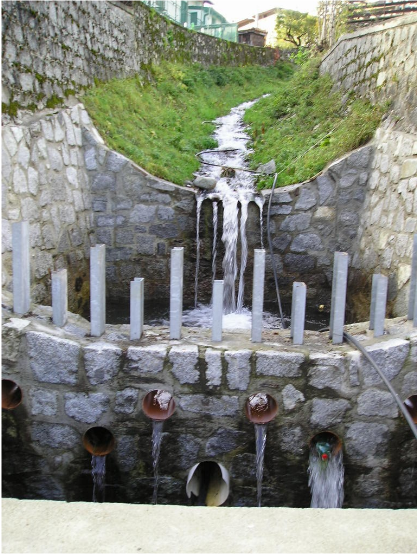
Foto 5: sezione 5 con, immediatamente a valle, la briglia di trattenuta
