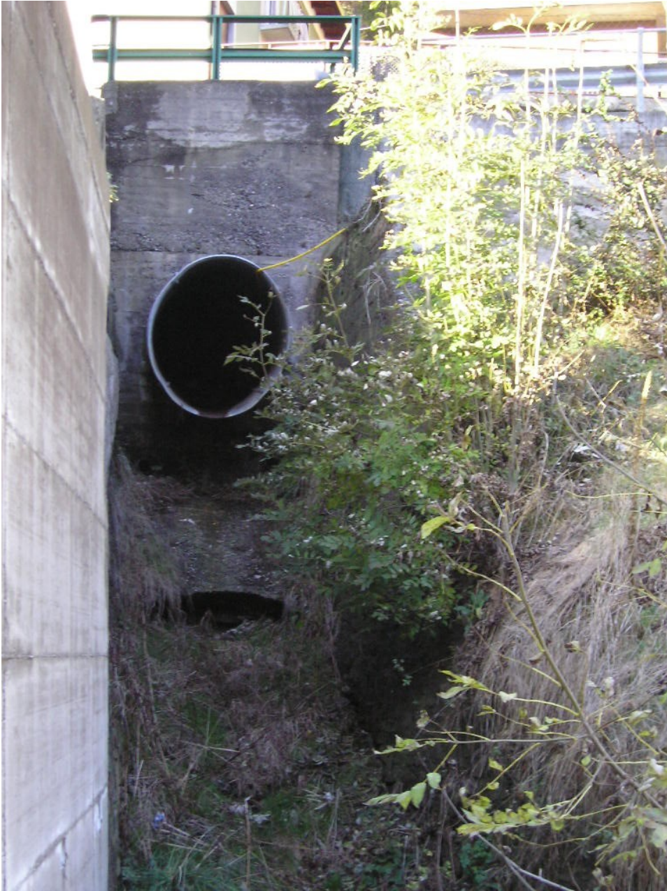
Foto 3: condotto di sezione circolare con diametro di 1.40m di Via Dante visto da valle
