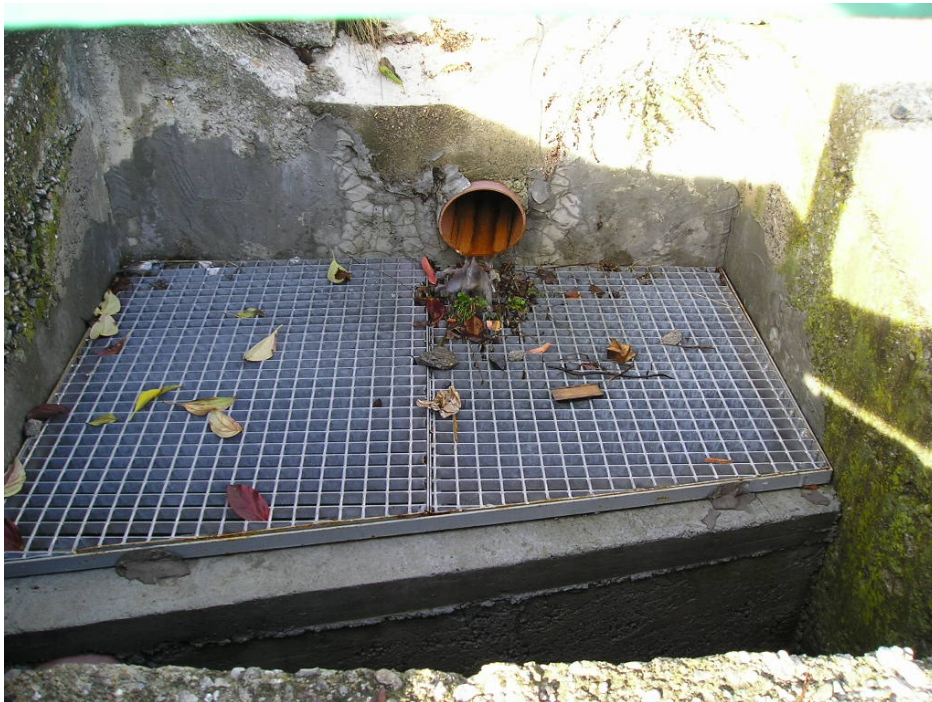
Foto 4: sezione 2, tombotto di Via Dante. Al di sotto del tubo uscente dalla vasca c'è il condotto circolare di 1.40m usato come sezione nelle verifiche idrauliche speditive
