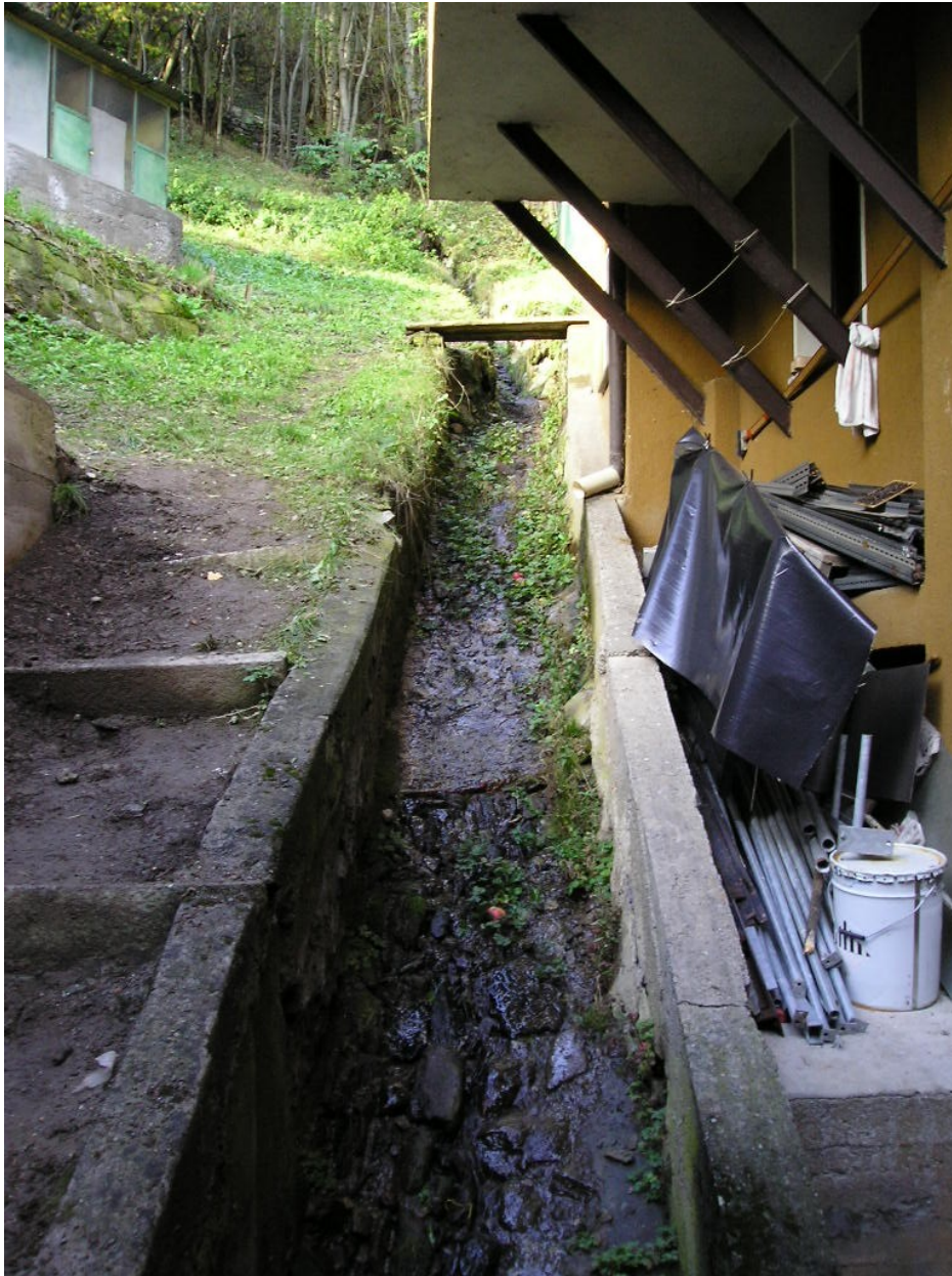
Tratto a monte di Via Dante, a ridosso degli edifici: l'alveo è completamente arginato con muri in calcestruzzo
