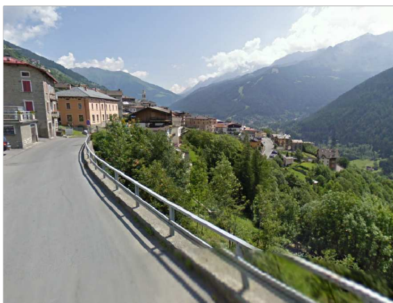
1 - Vista verso il nucleo di Vione
