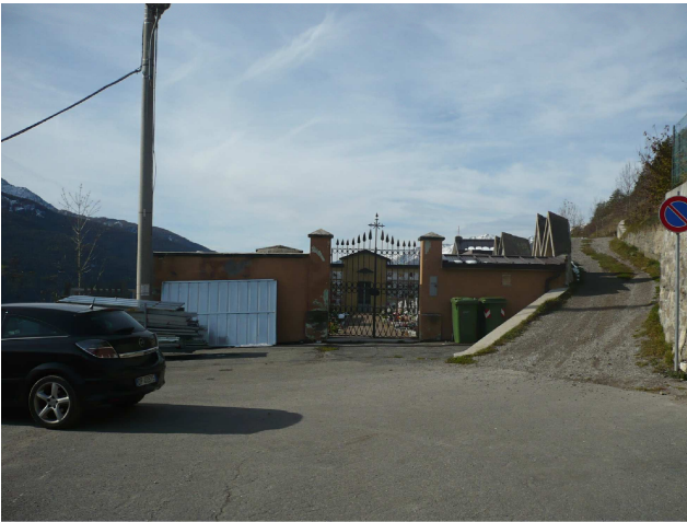
Esterno del cimitero di Canè
