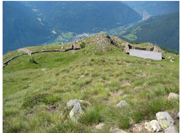
Sistema delle trincee e manufatto bellico
