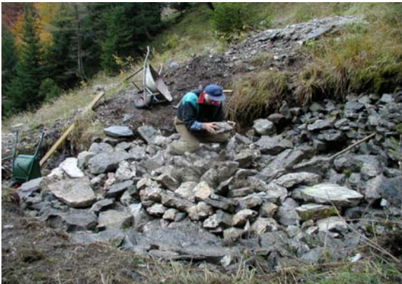
Figg. 70-71. Costruzione della calchera Culderana, Colere: l'involto (www.scalve.it).
