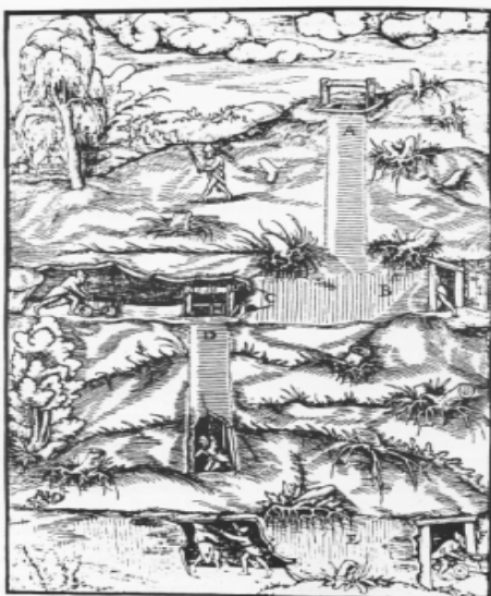
Figg. 47-48. Il sistema delle gallerie di una miniera e la Discesa nelle miniere (De Re Metallica di G. Agricola, 1494-1555) (FURIA, 2000, pp.10 e 14).
