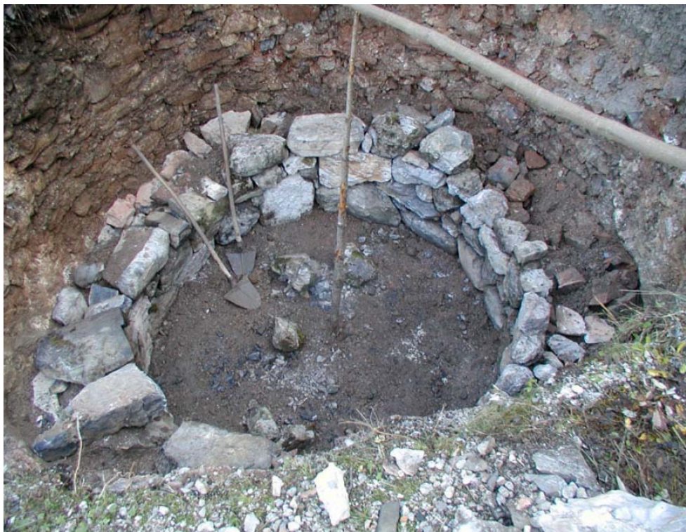
Fig. 67. Costruzione della calchera Culderana a Colere: la parte inferiore interrata (www.scalve.it).
