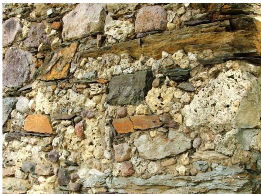
Fig. 93. Muratura tradizionale in pietra con intonaco a raso (COMUNITÀ MONTANA DI SCALVE, 2007).
