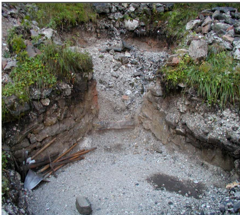
Fig. 69. Costruzione della calchera Culderana a Colere: scavo (www.scalve.i).
