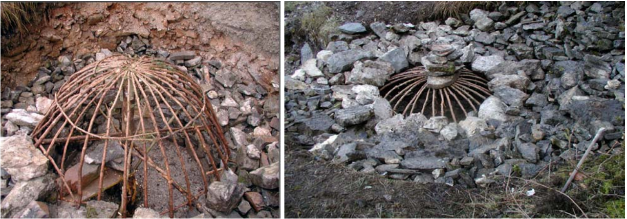
Figg. 70-71. Costruzione della calchera Culderana, Colere: l'involto (www.scalve.it).
