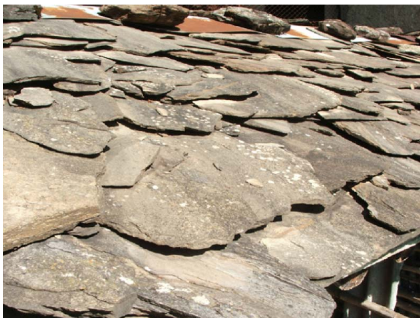
Fig. 94. Manto di copertura con pietra locale a spacco (COMUNITÀ MONTANA DI SCALVE, 2007).
