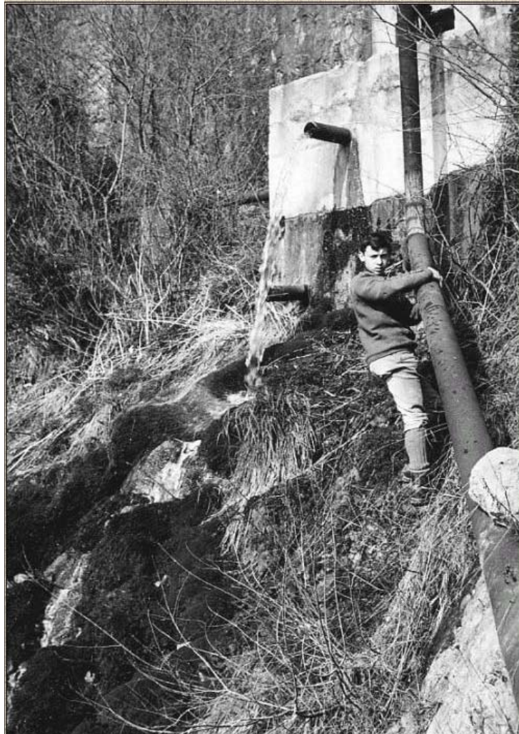
Figura 61. Due sorgenti nei pressi della Centrale Idroelettrica.
