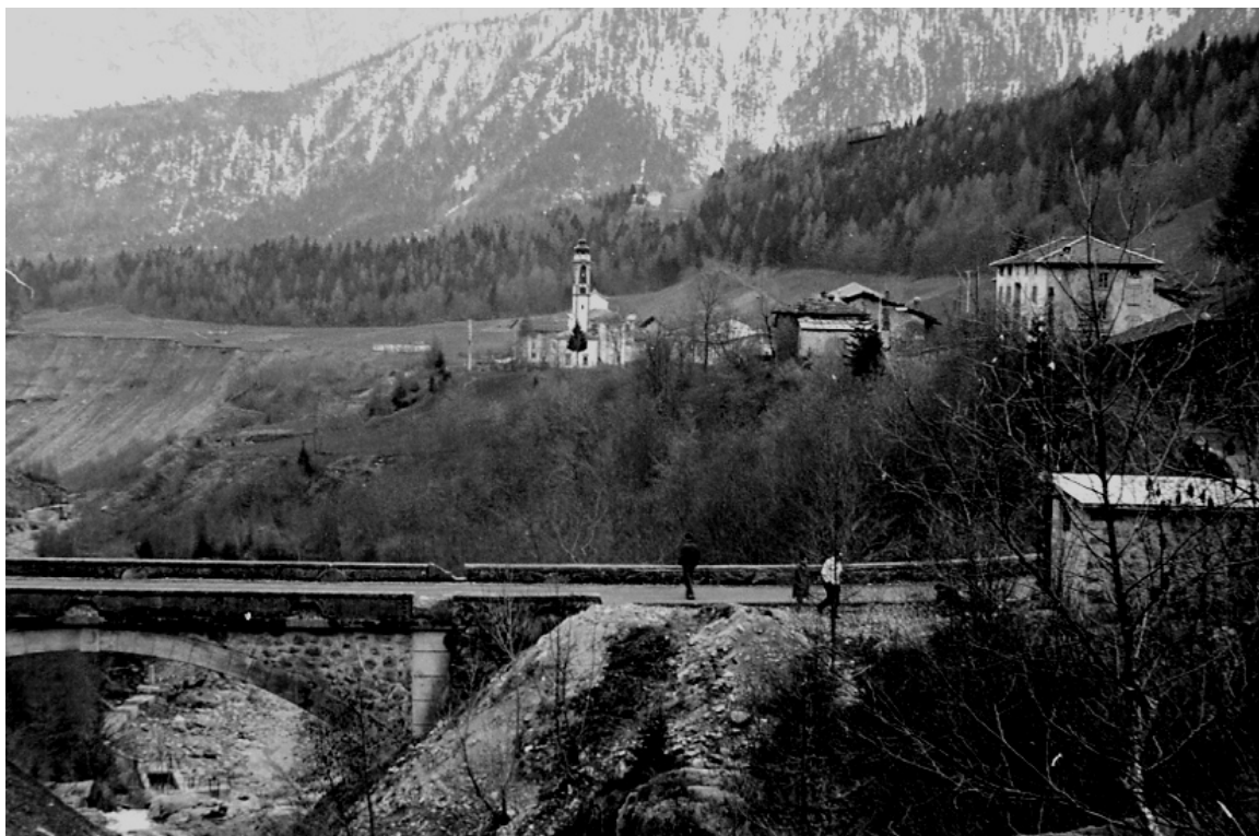
Figure 44, 45. Captazione di Bueggio.
