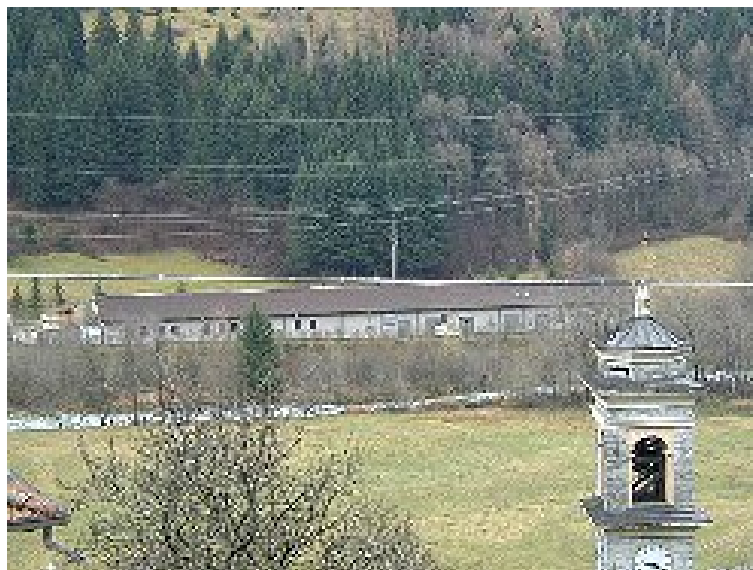
Figura 14: il depuratore nella frazione di Davena
