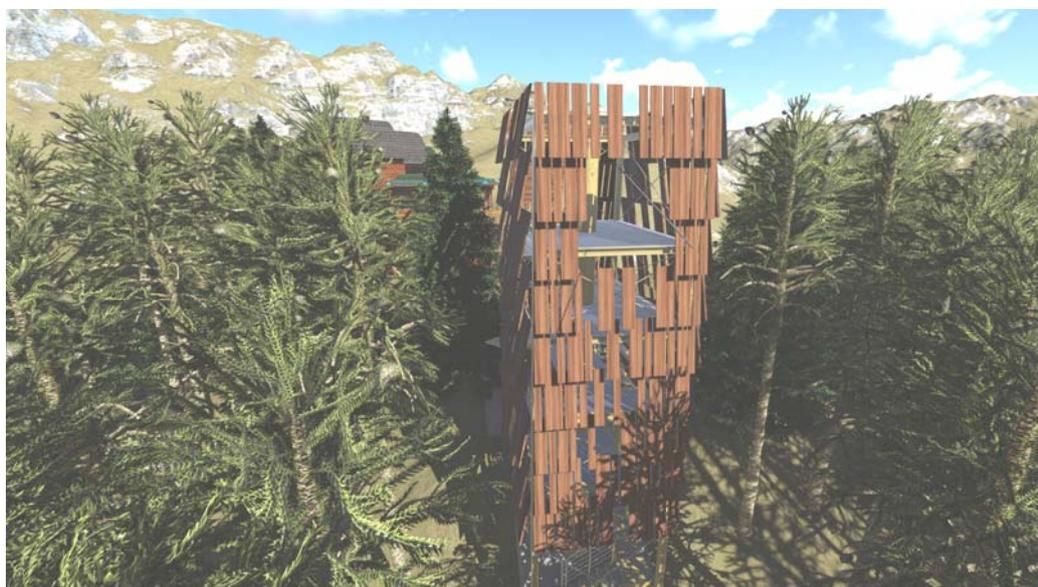
La vista tridimensionale rappresenta la torre della stazione Roccolo, essa è alta circa 13 metri, è inserita all'interno del bosco ed ha struttura portante in carpenteria metallica, la base in cemento armato ed un rivestimento aperto in legno.
