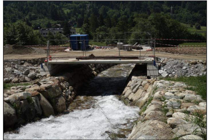
Nuove opere di mitigazione del rischio per esondazione e trasporto in massa lungo il conoide Torrenet Fiumeclo realizzate tra il 2012 e il 2013 nella zona distale del conoide sotto la S.S. n. 42 del Tonale (risezionamento alveo, realizzazione di scogliere e soglie di fondo)
