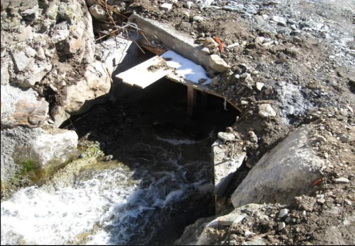
Punto critico dovuto ad un attraversamento troppo piccolo a quota 1333,9 m con restringimento della sezione e possibile fuoriuscita del flusso
