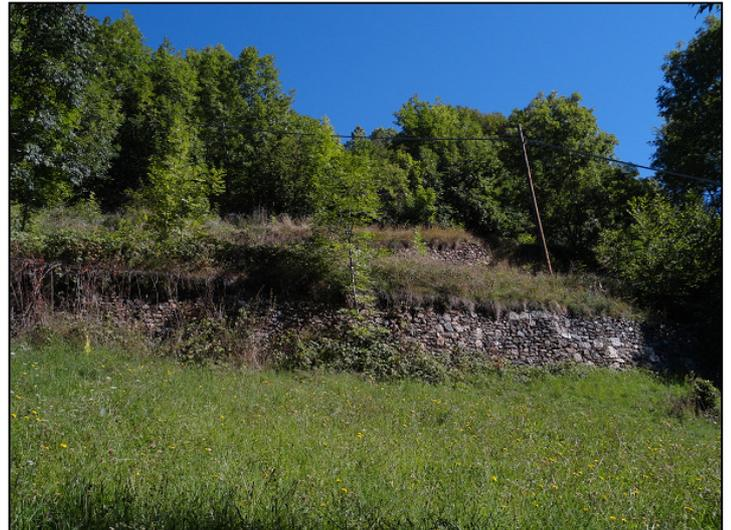
Versante in Loc. Gas oggetto di perimetrazione. Il settore centro-occidentale (foto a sinistra) è caratterizzato da una pericolosità alta (presenza di acqua e alberi inclinati) mentre il settore orientale (foto a destra) è più stabile per la presenza di muretti in pietrame a secco e dei terrazzamenti agrari.
