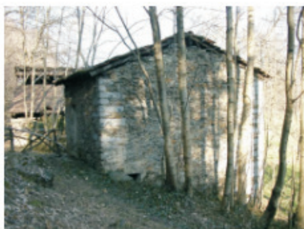
FABBRICATO 2: PROSPETTO SUD
