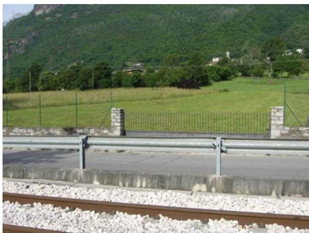
Vista verso ovest
