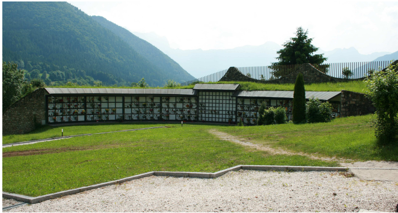
I loculi di recente realizzazione
