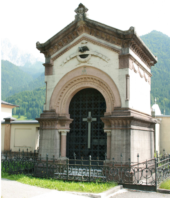
La cappella privata posta a nord – ovest
