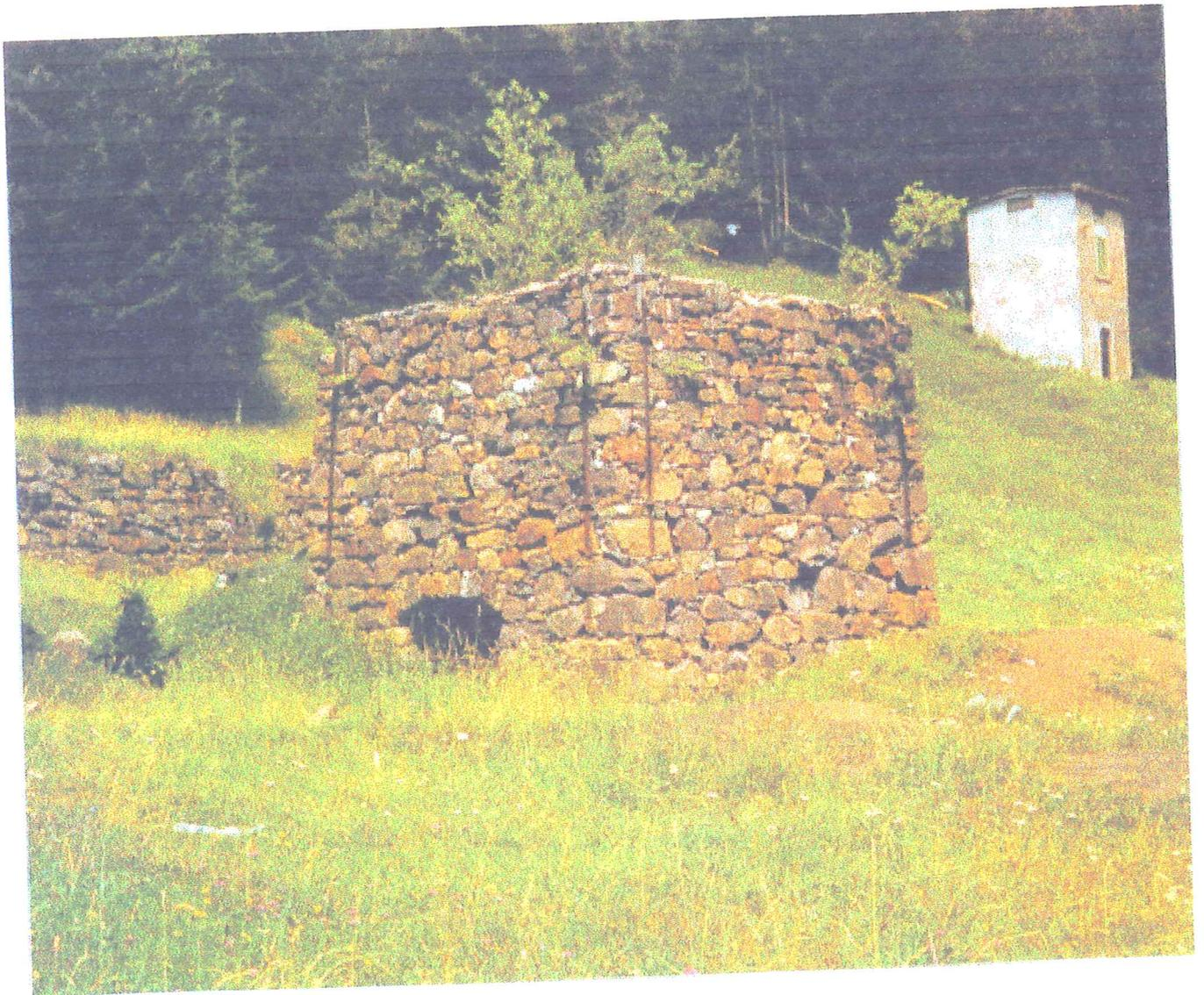
Antico forno per la torrefazione dei minerali di ferro a Schilpario
