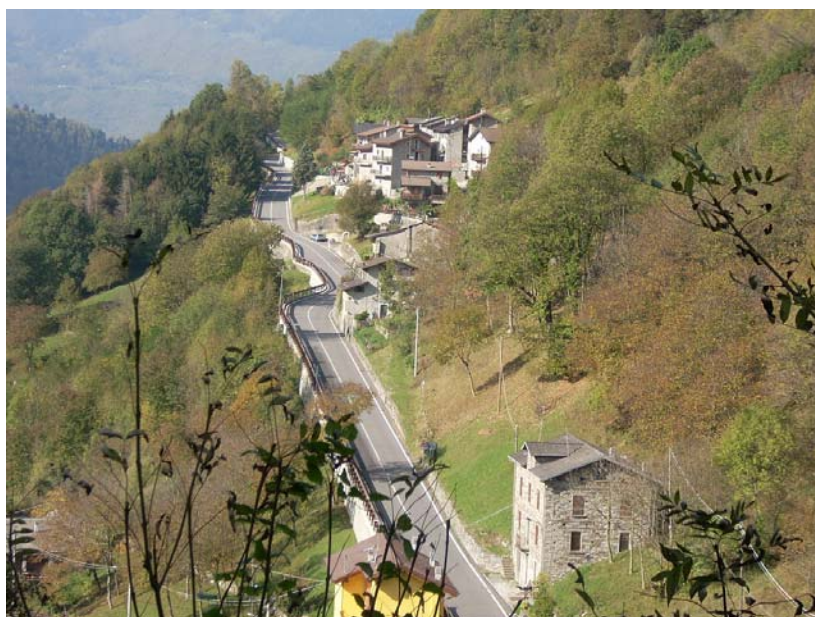
Strada di collegamento Saviore - Fresine
