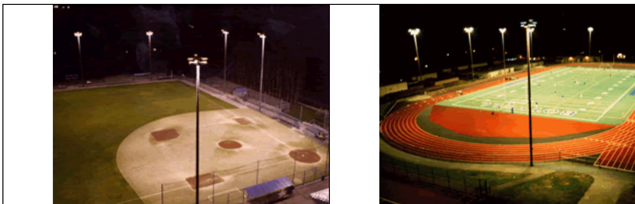
Figura 7.113 – Impianti sportivi di grandi dimensioni realizzati con proiettori asimmetrici installati orizzontali e nello specifico: Campo di calcio con pista di atletica e impianto di Baseball.
