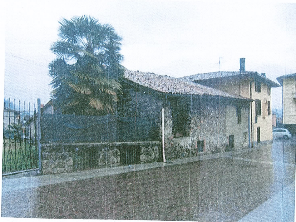
Fabbricato in oggetto visto da nord - ovest
