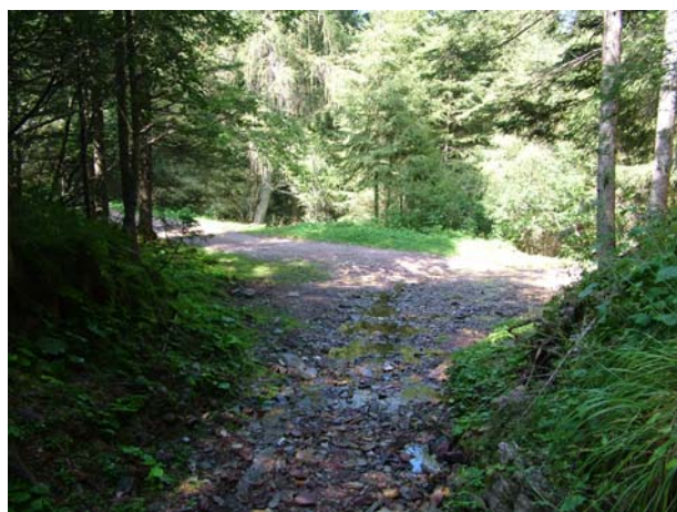
Foto 6. Vista a valle dell'opera di presa
