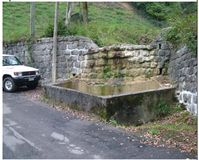
Foto 8. Briglia e vasca a monte del tombotto Opera X-Z. Quota 670.00 m.s.l.m.
