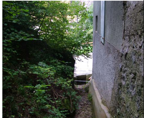
Foto 2. Tratto a monte dell'attraversamento A al di sotto della strada
