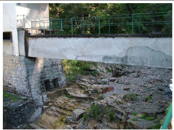
Foto 4. Alveo del torrente nei pressi del ponte del canale idroelettrico
