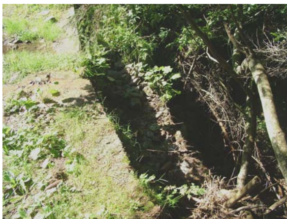
Foto 7. Gabbioni a valle della strada
