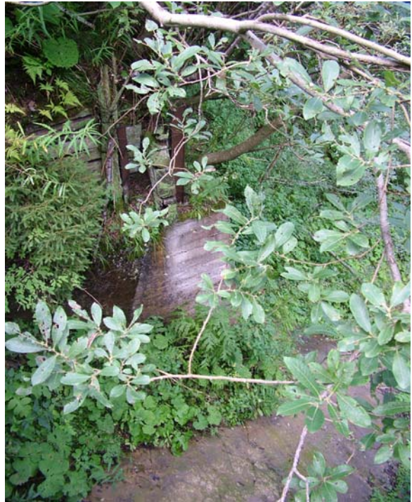
Foto 4. Dettaglio spalla del ponte
