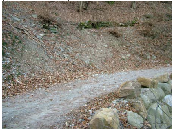
Foto 4. Vista attraversamento (quota 758 m s.l.m.)
