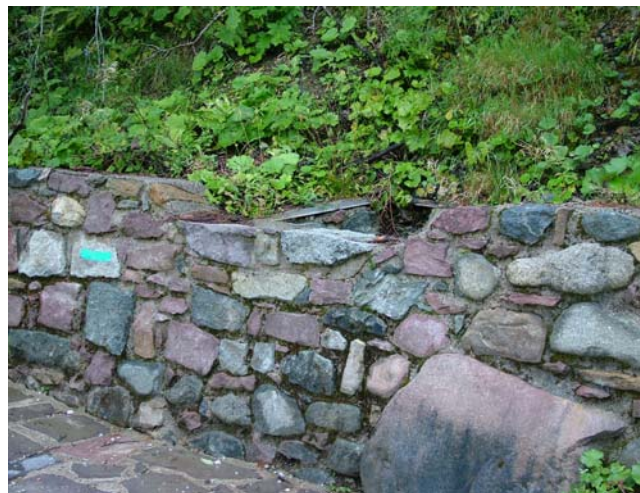
Foto 2. Particolare tombotto a monte della strada
