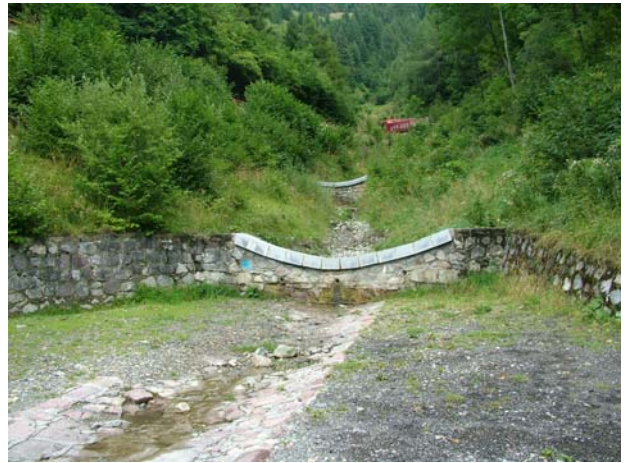
Foto 4. Briglia e guado Opera E Quota 1406 m s.l.m.
