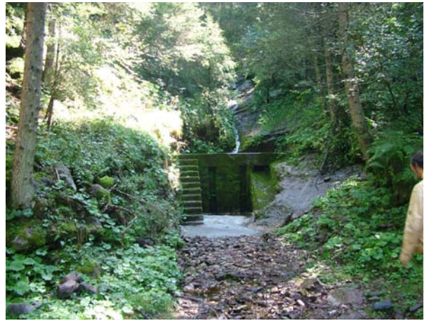
Foto 4. Opera di presa
