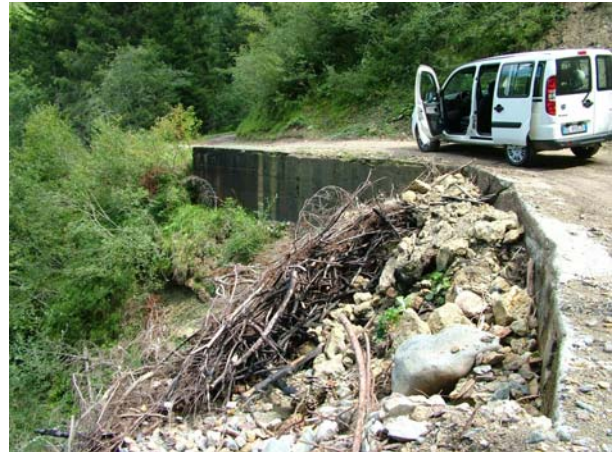
Foto 4. Alveo a valle dell'attraversamento B
