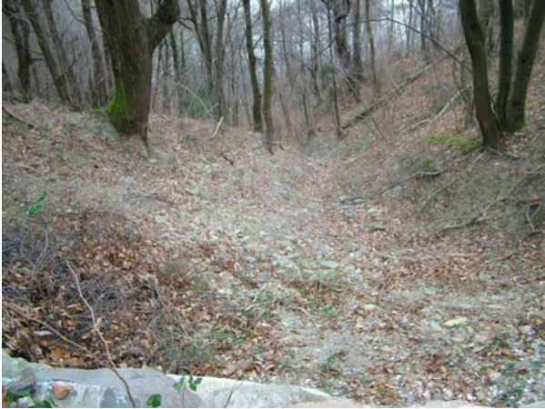
Foto 3. Vista a valle dell'attraversamento (quota 758 m s.l.m.)
