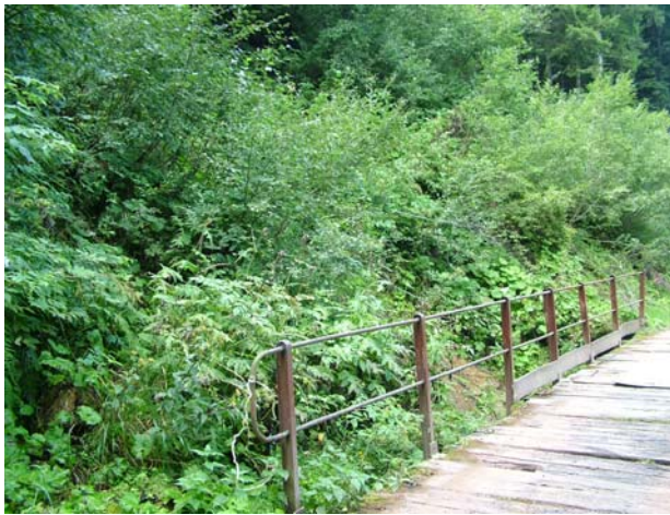
Foto 3. Ponte in ferro e legname
