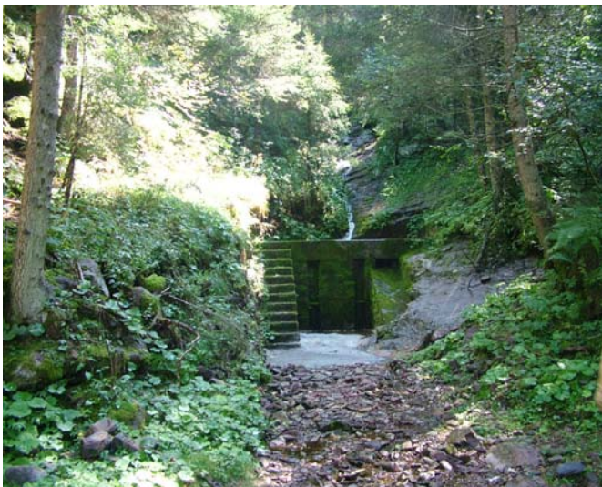
Vista alveo a monte dell'attraversamento
