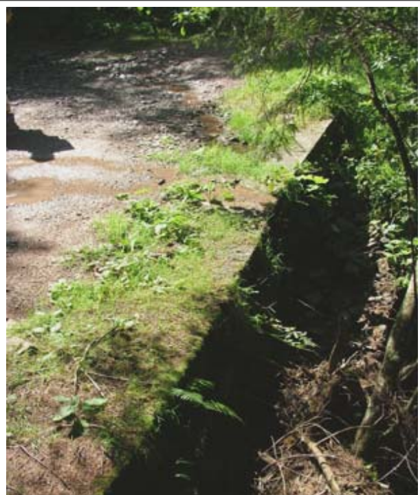
Foto 8. Manufatto a valle della strada
