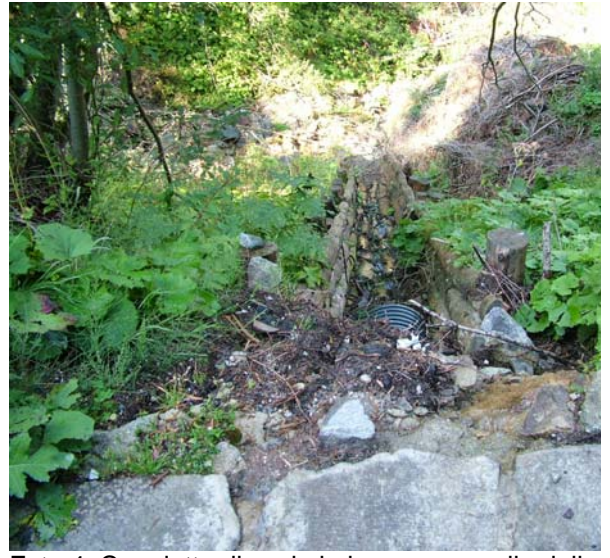
Foto 4. Canaletta di scolo in legname a valle della strada
