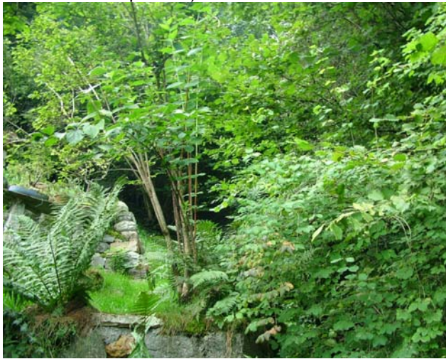
Foto 1. Tratto a monte del tombotto A (presenza di alcune difese spondali)
