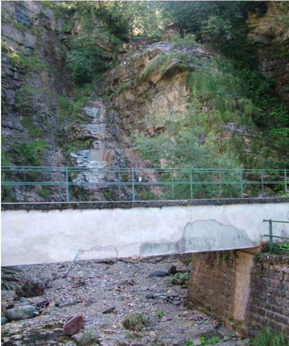
Foto 3. Alveo del torrente nei pressi del ponte del canale idroelettrico
