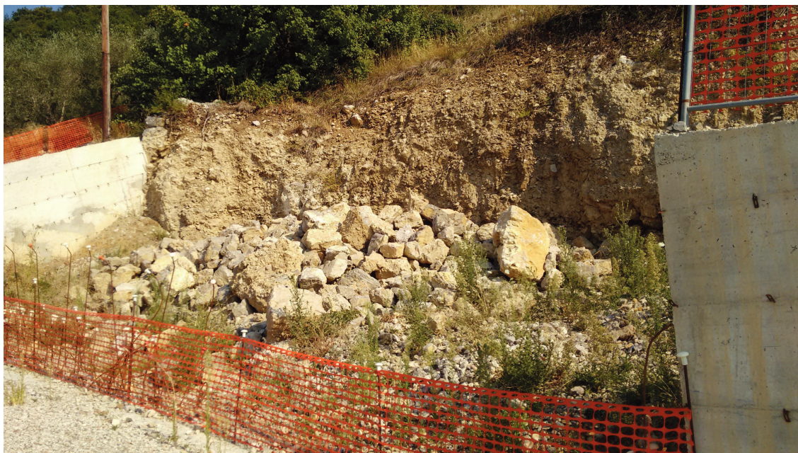
Figura 2 - le condizioni del substrato litologico nello scavo aperto
