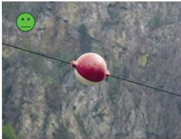
Sfera di poliuretano (da Linee Guida del Ministero dell'Ambiente per la Mitigazione dell'Impatto delle Linee Elettriche sull'Avifauna - Pirovano & Cocchi 2008).
