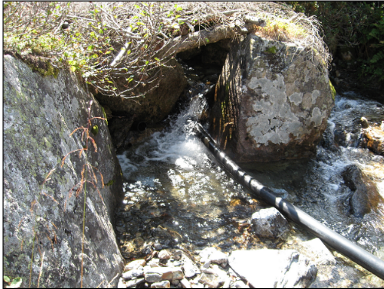
Dettaglio del punto di presa
