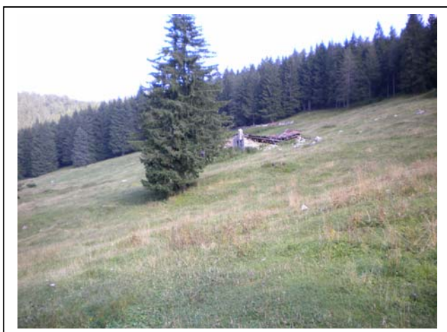
Strutture fatiscenti completamente da ristrutturare presso la Malga Val Sorda
