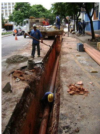
scavo in trincea
