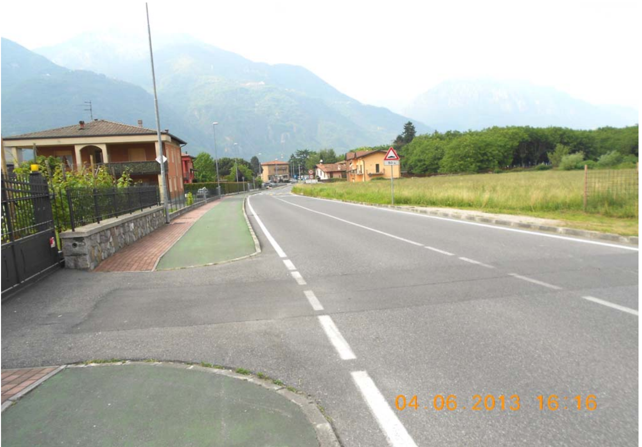
P.A.r.17a Zona oggetto di intervento Foto 9/9
