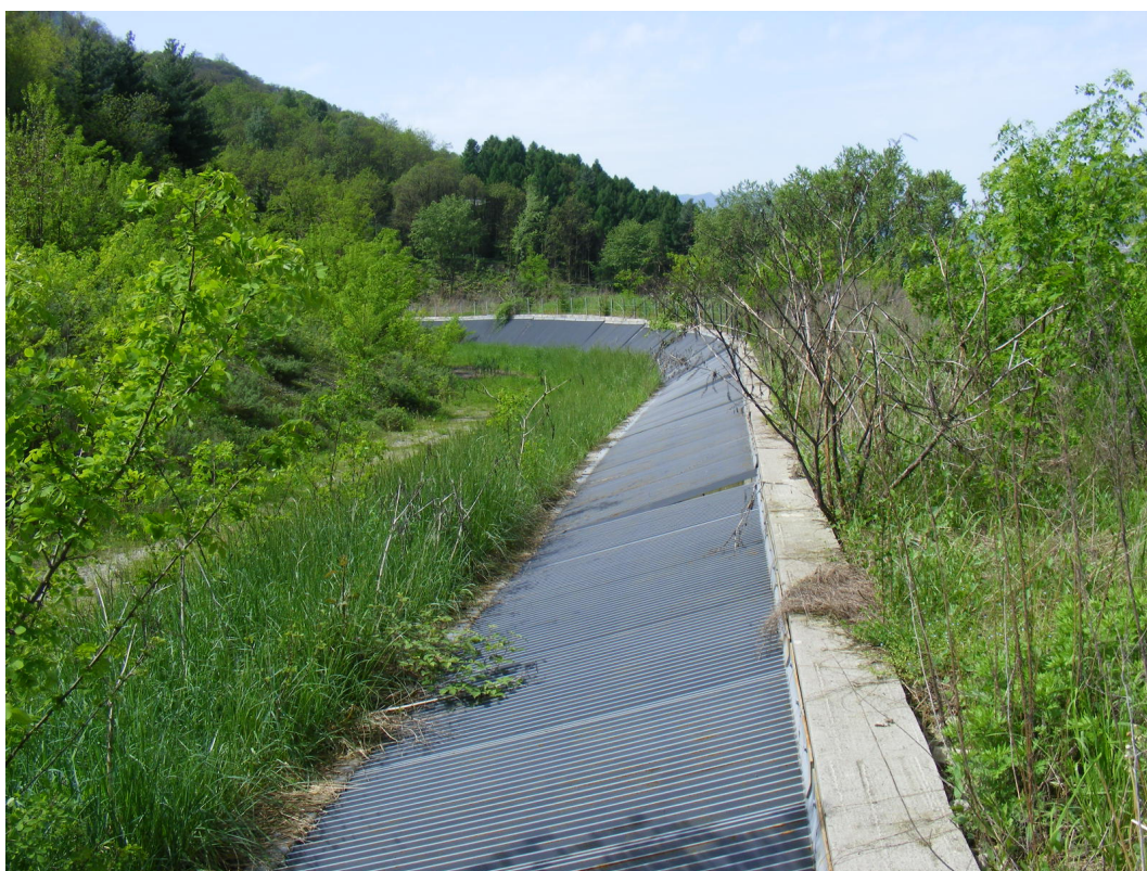
Settore centrale della vasca di sedimentazione.
