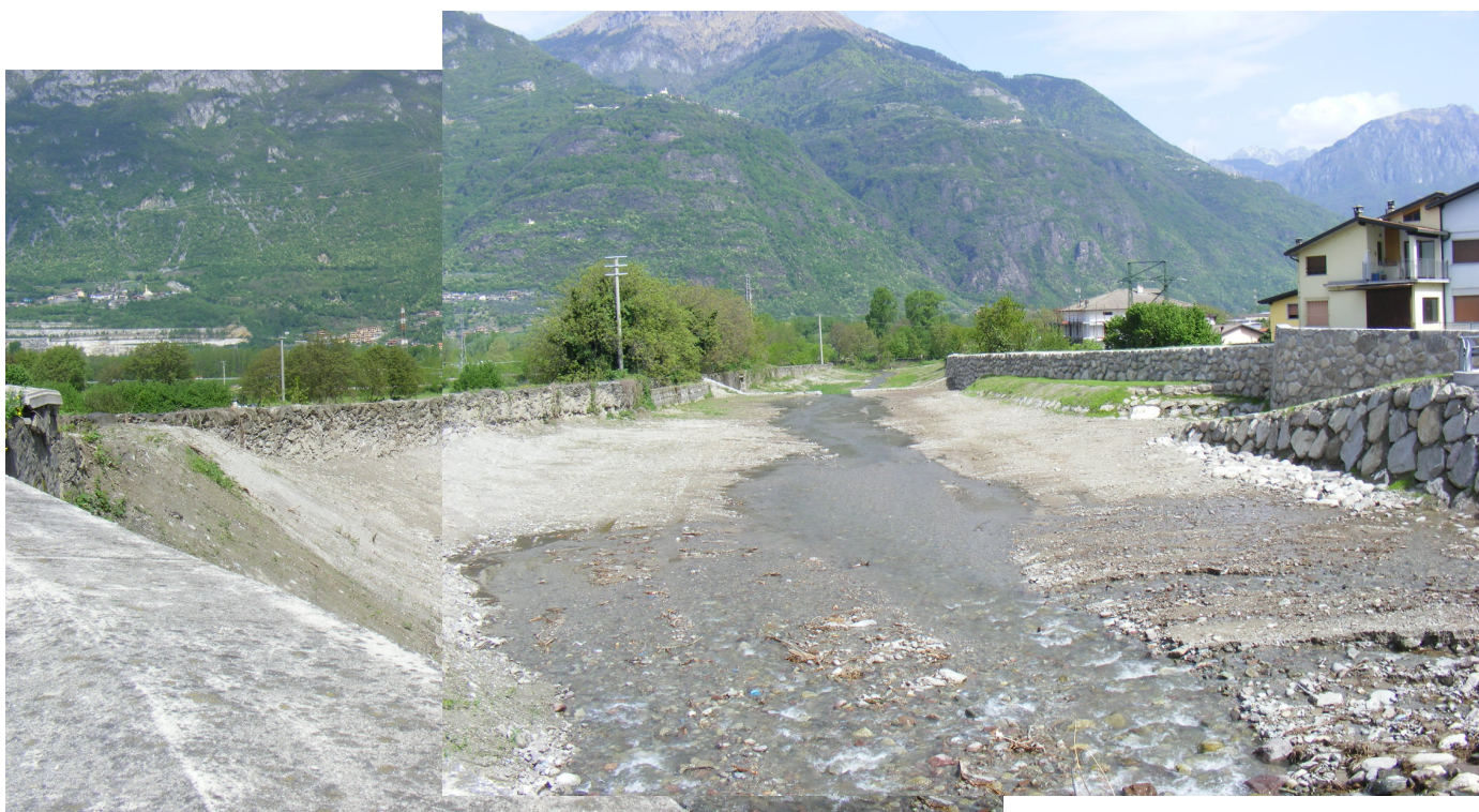
Torrente Re. Tratto medio-inferiore del conoide, subito a valle del ponte di via XXV Aprile.
