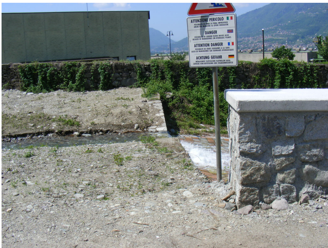
Torrente Re di Gratacasolo. Prima briglia a monte del ponte di via XXV Aprile.
