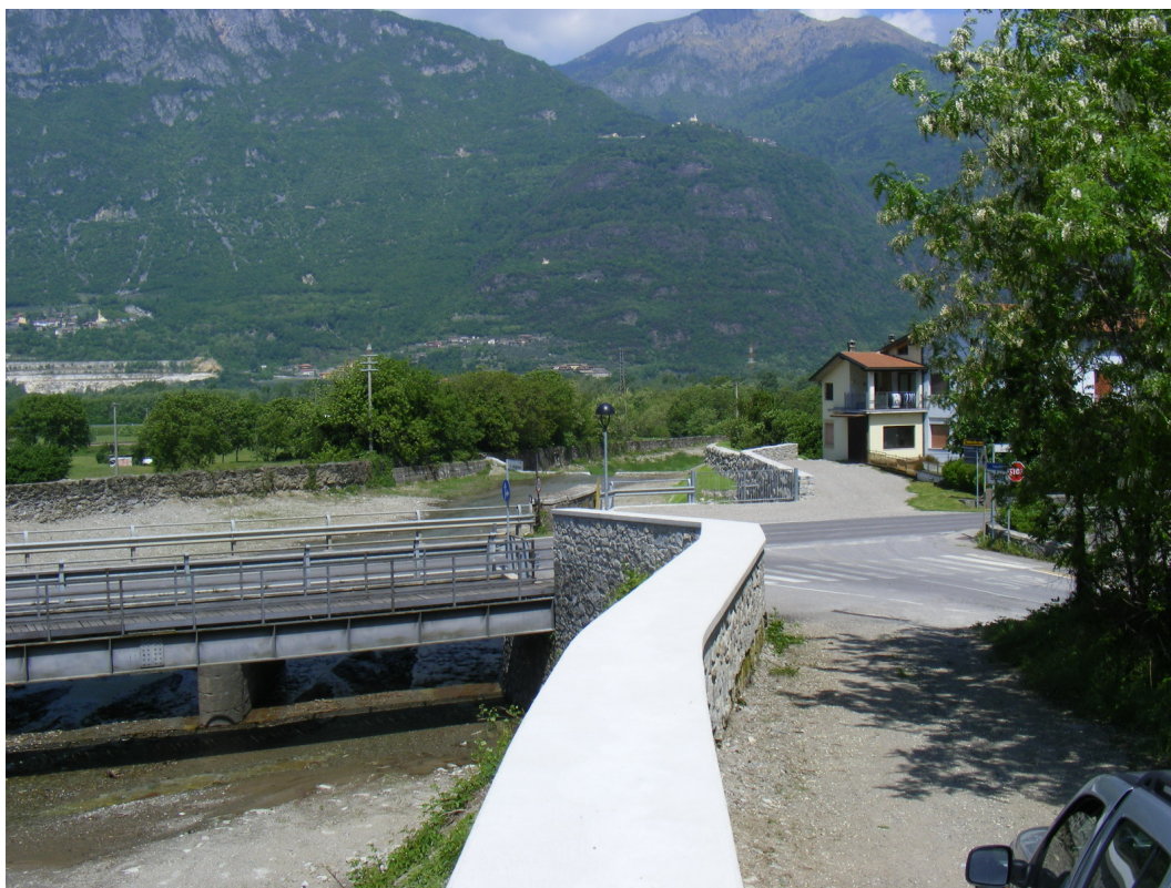
Torrente Re di Gratacasolo. Sponda destra in corrispondenza del ponte di via XXV Aprile.
