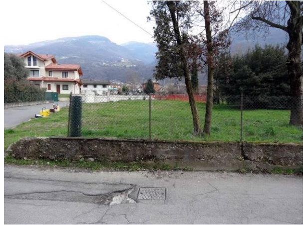
vista da via G.Verga
