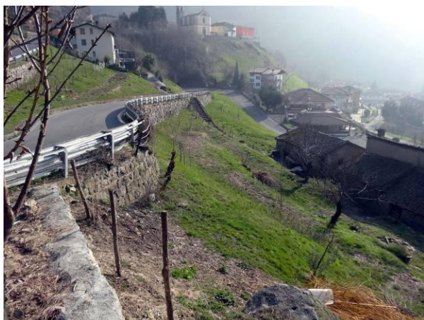
vista dell'ambito con la S.P. 95 (via Mazzoletti)
