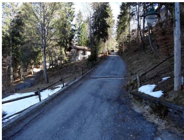
vista della strada d'accesso
