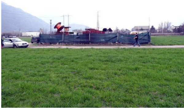
vista dalla strada di campagna a Sud
