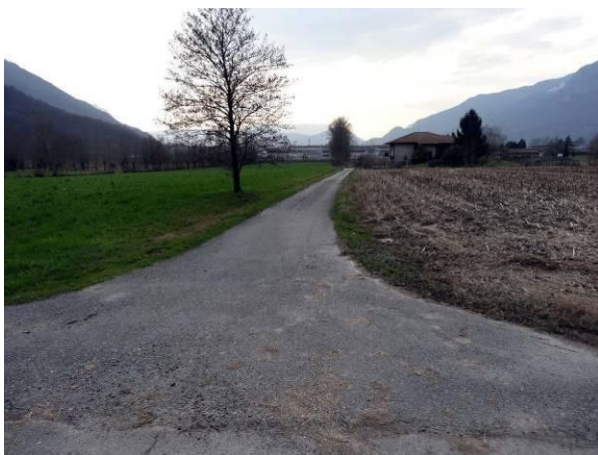
vista da via Battaglione Edolo: traversa interna all'ambito
