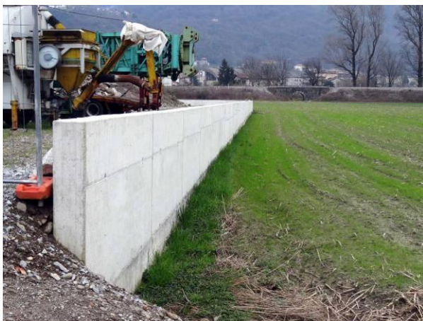
vista dalla traversa di via Dossi
