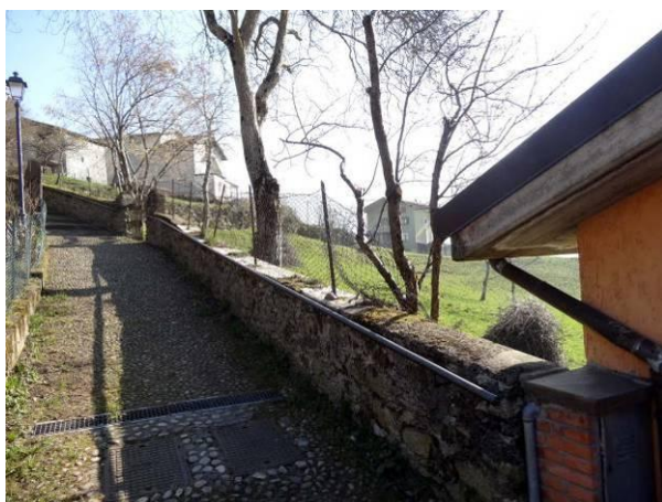
vista della strada d'accesso (via della Chiesa)
