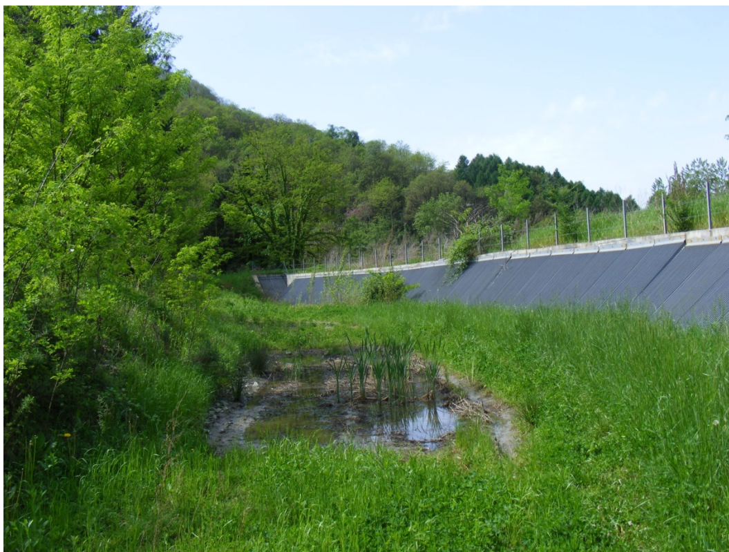
Settori ovest e centrale della vasca di sedimentazione; la pozzanghera si trova in corrispondenza del punto di arrivo della Valle del Fossato.
