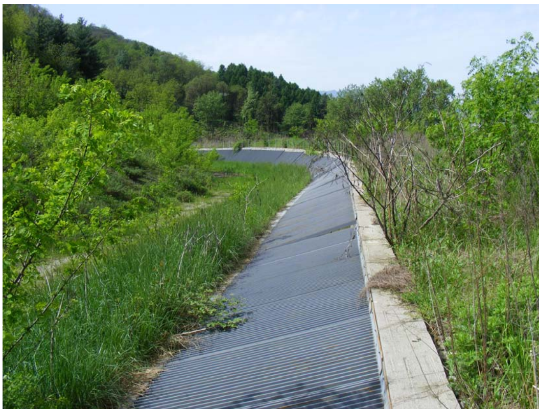
Settore centrale della vasca di sedimentazione.
