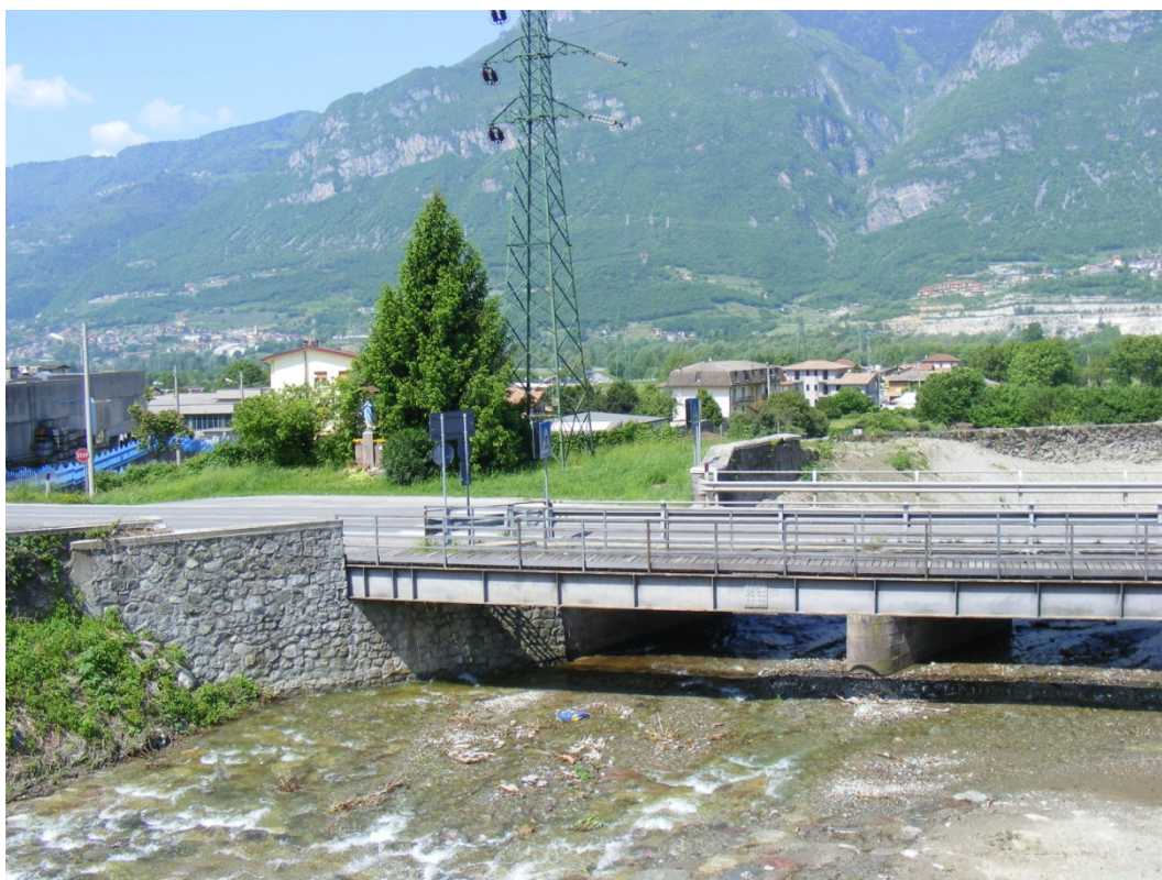
Torrente Re di Gratacasolo. Sponda sinistra in corrispondenza del ponte di via XXV Aprile.
