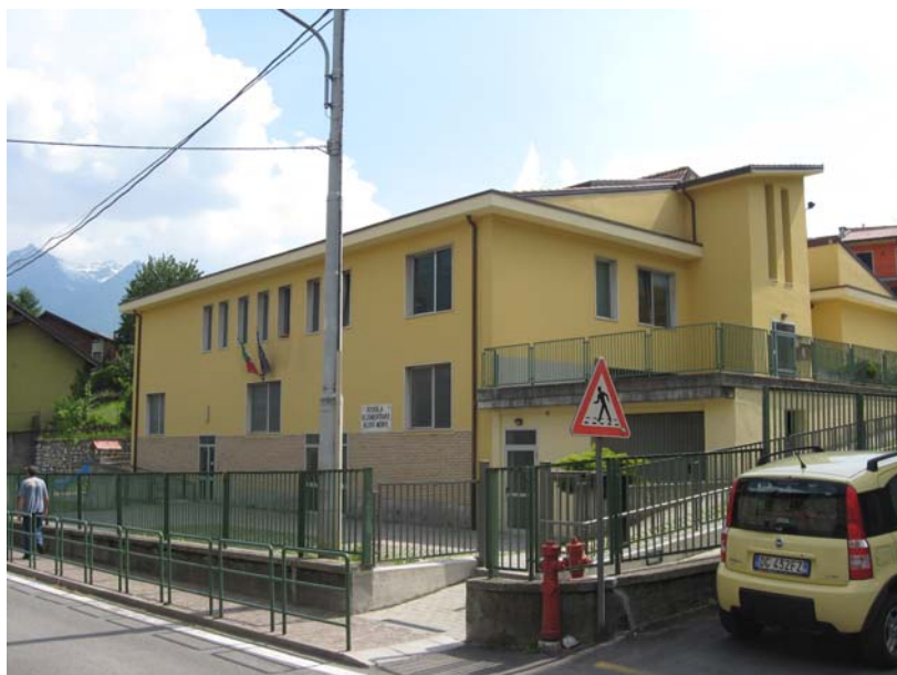
L'edificio scolastico che ospita la scuola elementare Aldo Moro e la scuola materna
