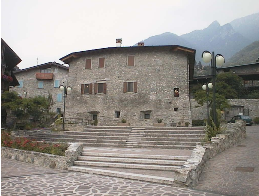
edificio ex casa Poli – centro diurno integrato
