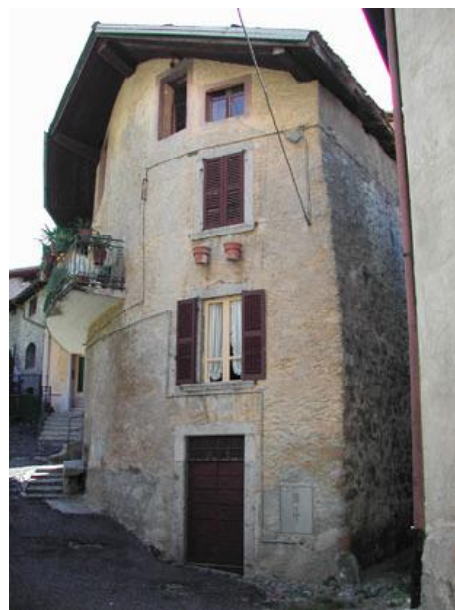
Esempi di edifici già trasformati
