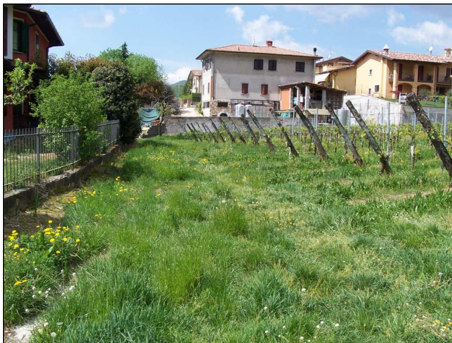
Il centro abitato in corrispondenza della tombinatura del corso d'acqua
