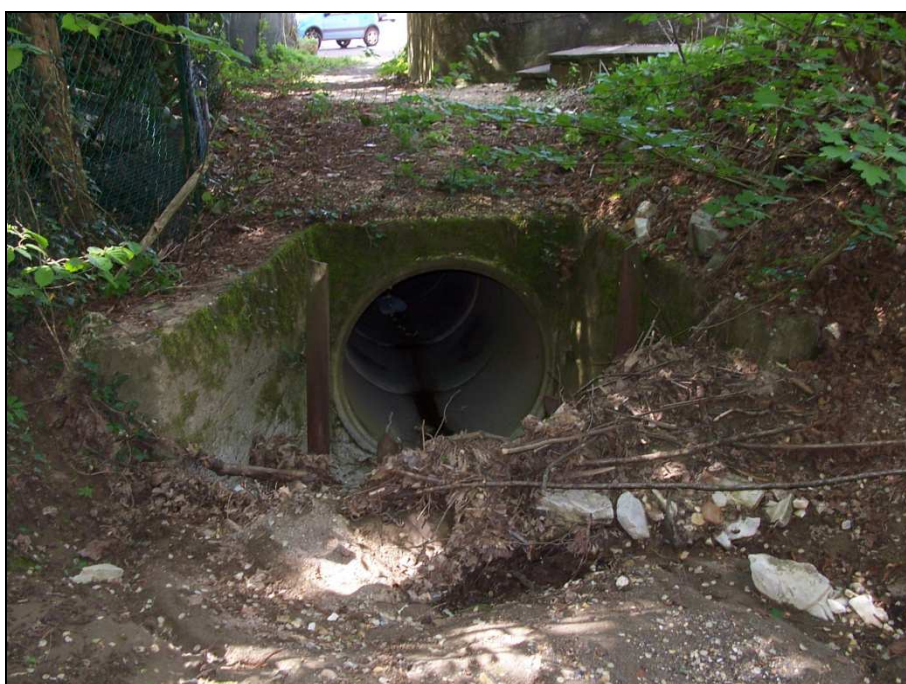
Il Fosso Valle Sotto dei Dossi immediatamente a monte della tombinatura di attraversamento del centro abitato
