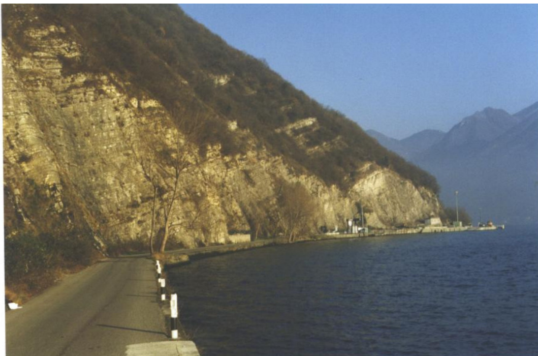
Foto 7: versante est dell'isola, con pareti sub – verticali. Strada Peschiera - Carzano
