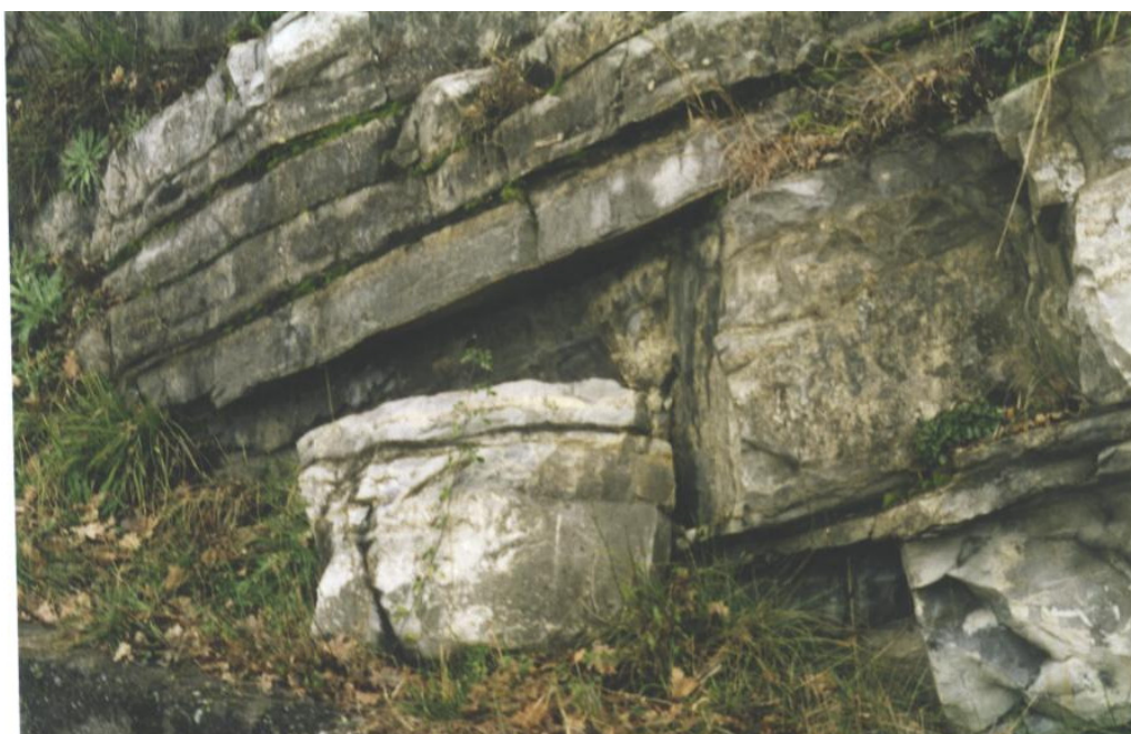
Foto 10: particolare delle condizioni strutturali dell'ammasso che provoca i crolli
