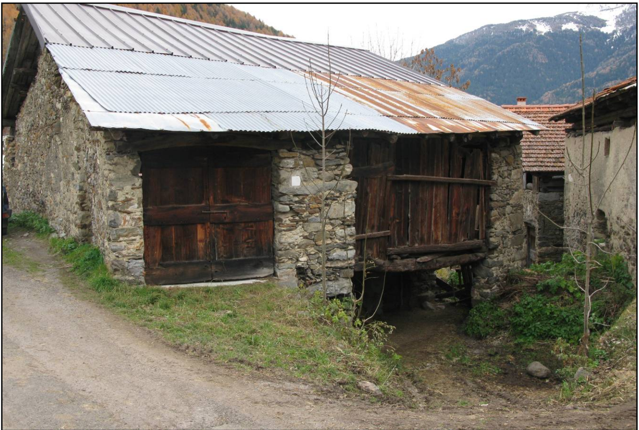
Foto 18 – Edificio rurale in località Lucco
