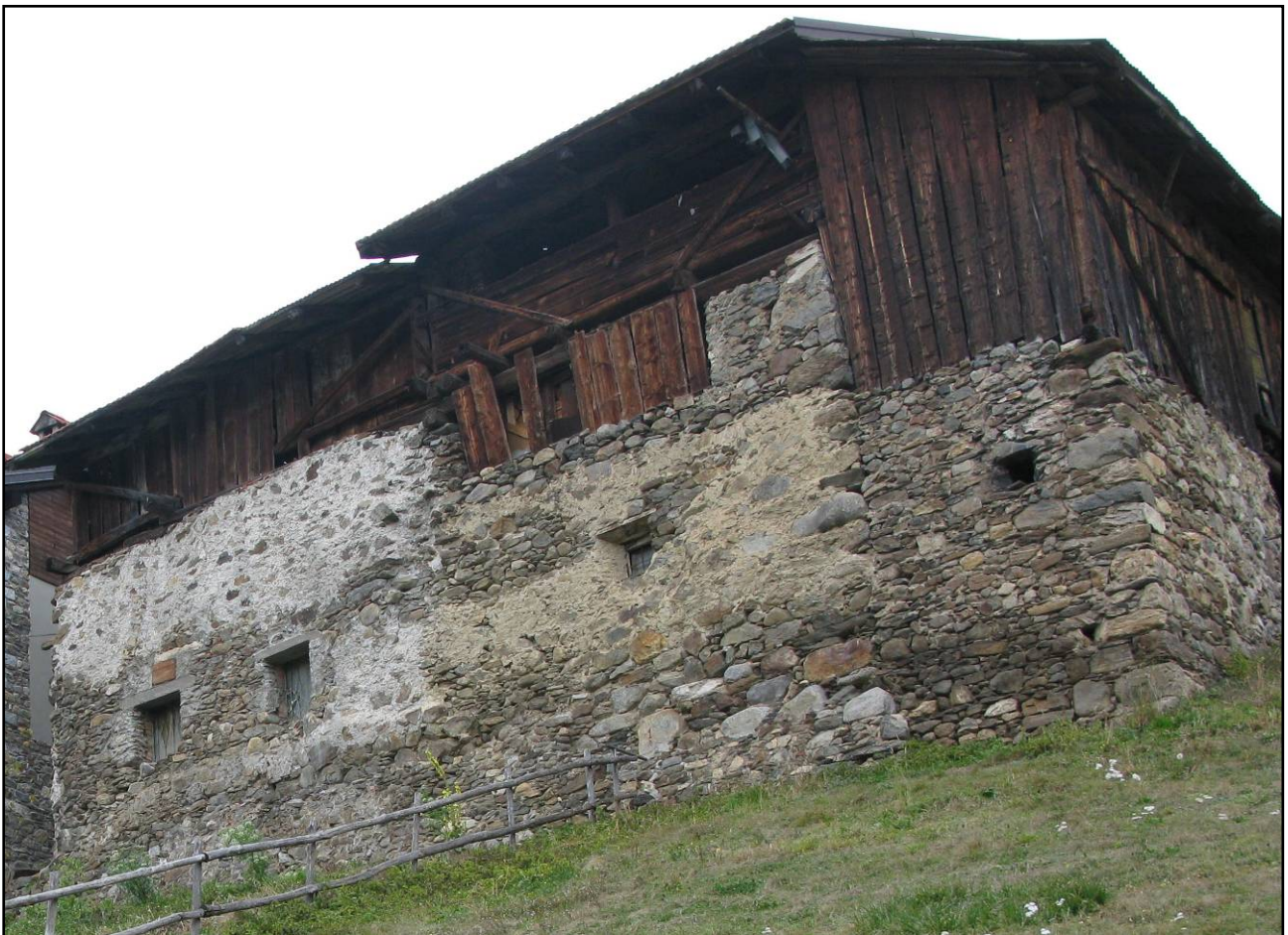
Foto 16 – Edificio rurale in località Lucco
