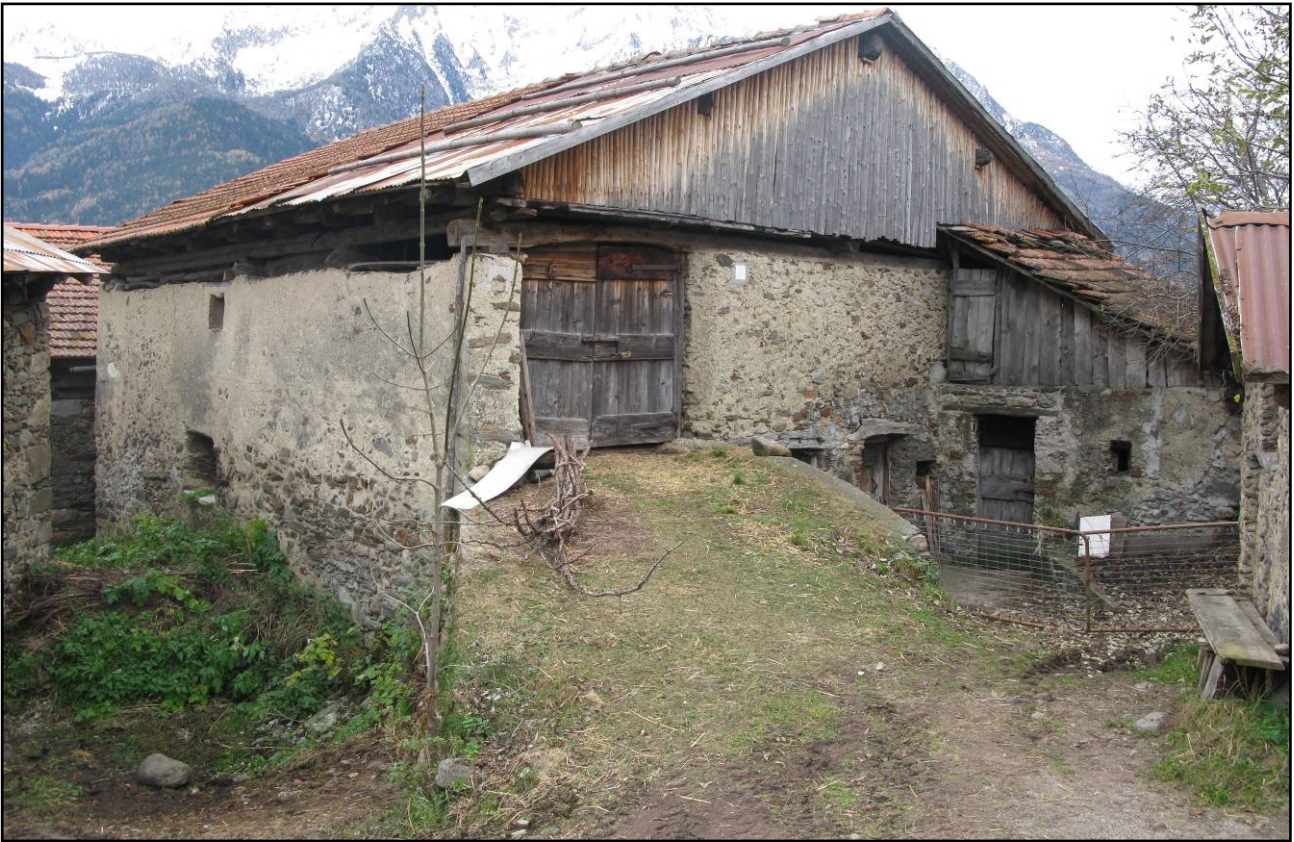
Foto 17 – Edificio rurale in località Lucco
