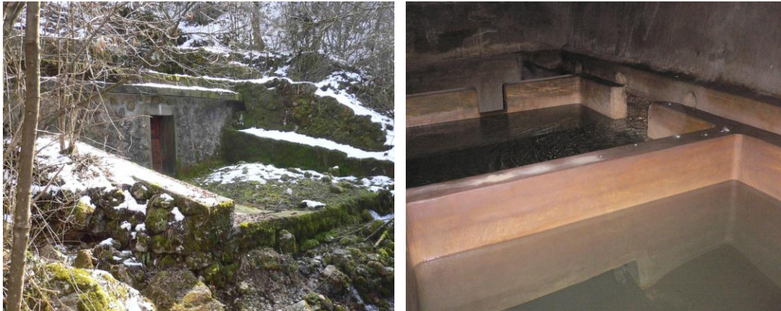
La sorgente in Valle di Torrezzo
