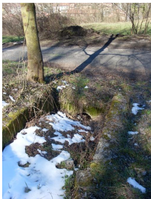
Tubature intasate lungo la Stradella della Vidalba
