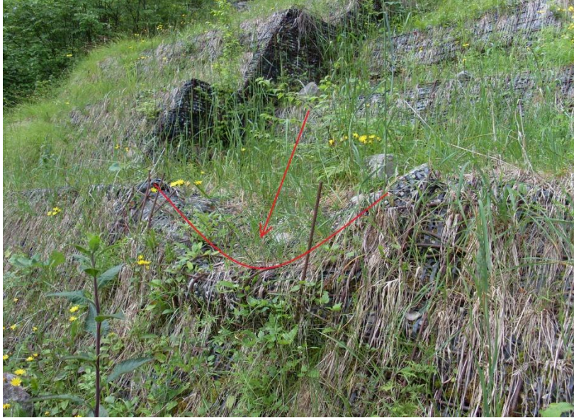
Cratere d'impatto nelle terre armate presenti nella parte alta della Valle Spirola
