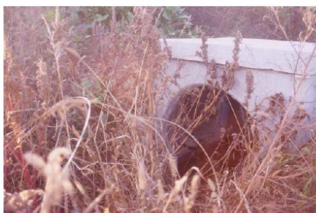
Tunnel per anfibi
