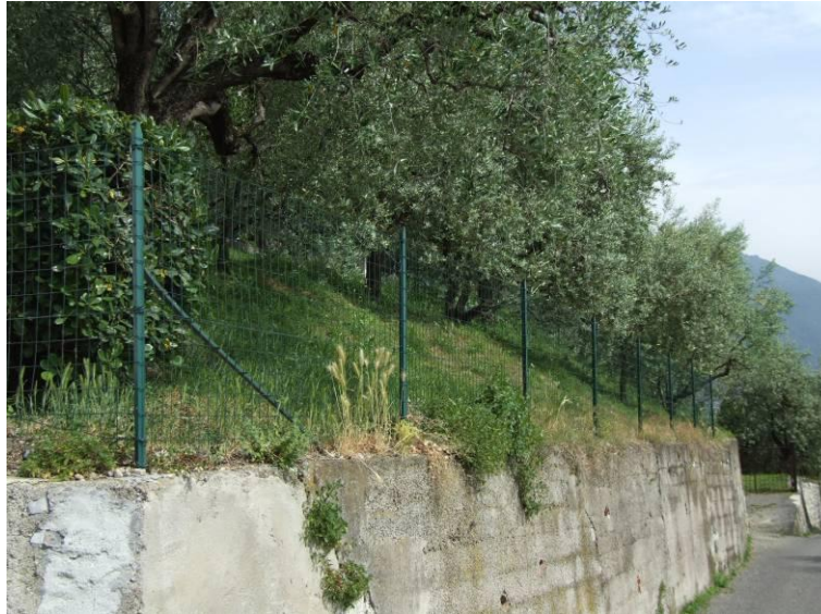
vista da via strada a valle dell'Adt
