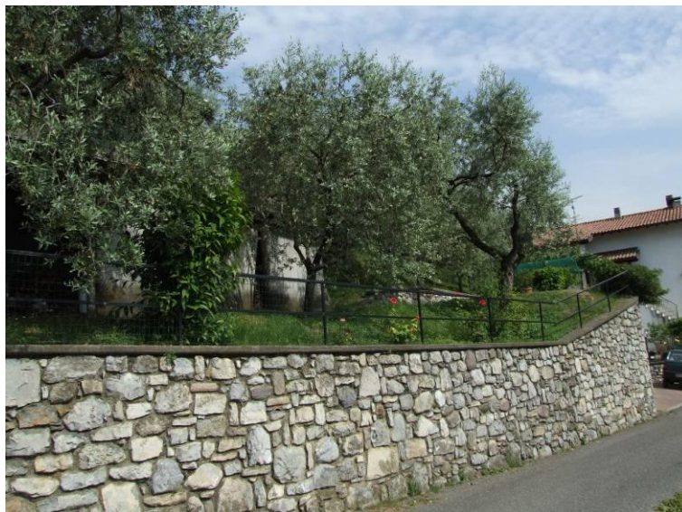
vista da via strada a valle dell'Adt
