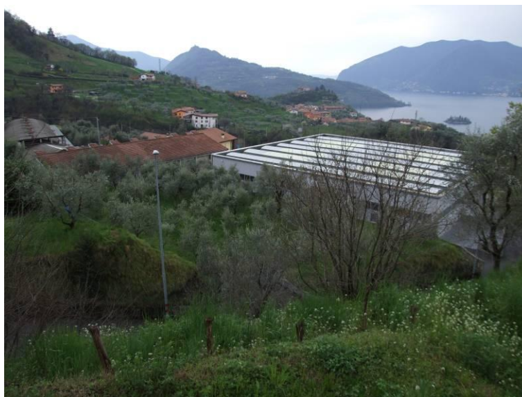
vista da via grumello
