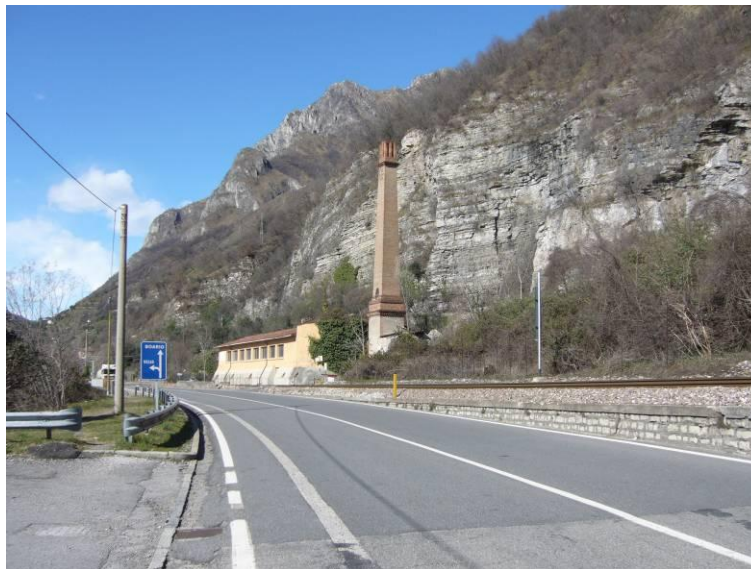
vista da via de gasperi
