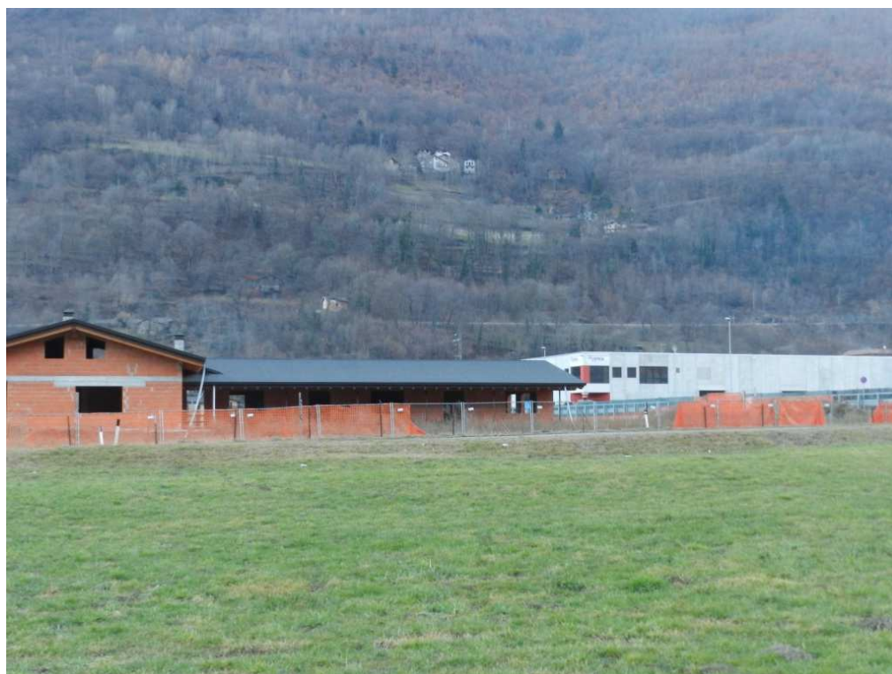
Figura 13: Costruzione civile sulla quale è stato indicato il varco della RER
