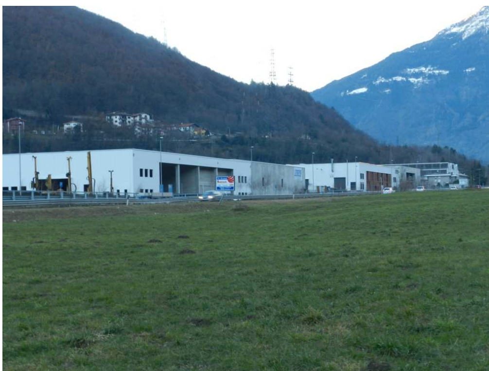
Figura 16: Particolare dei magazzini del polo industriale di Malonno
