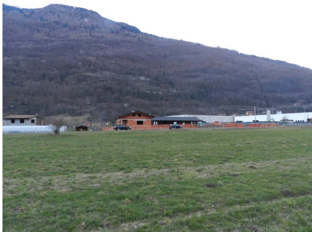
Figura 14: Visione d'insieme: si nota la costruzione civile, a sinistra le serre e il magazzino del Vivaio e a destra l'area industriale
