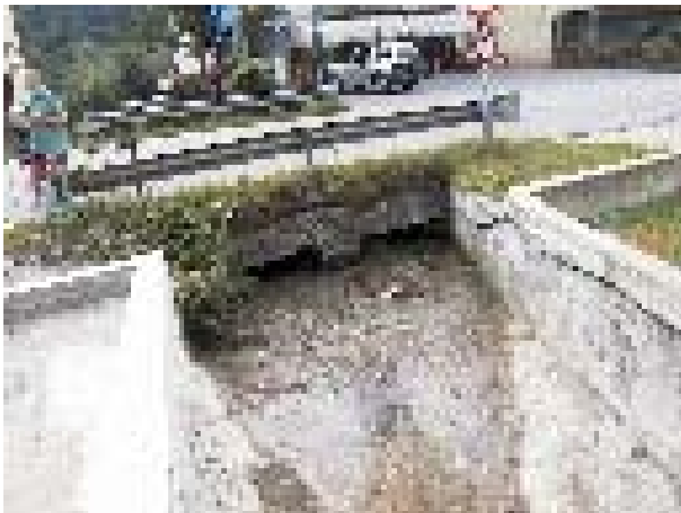
Foto 6: tombotto intasato lungo la SS 42
