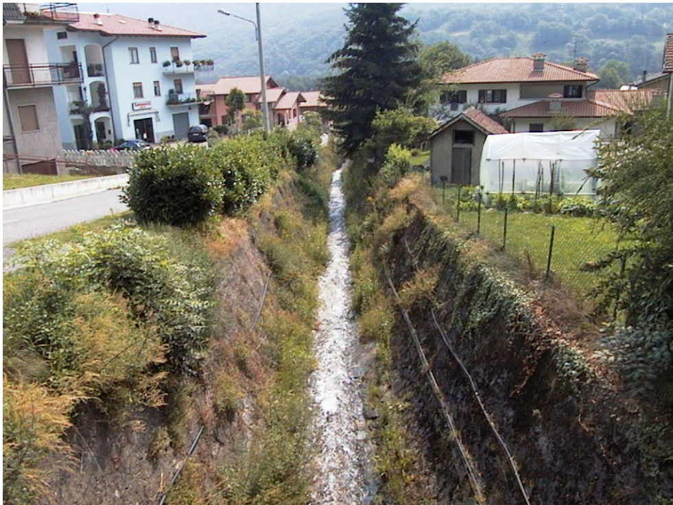
Foto 4: sezione 4, tratto di alveo regimato a valle del tombotto n°3
