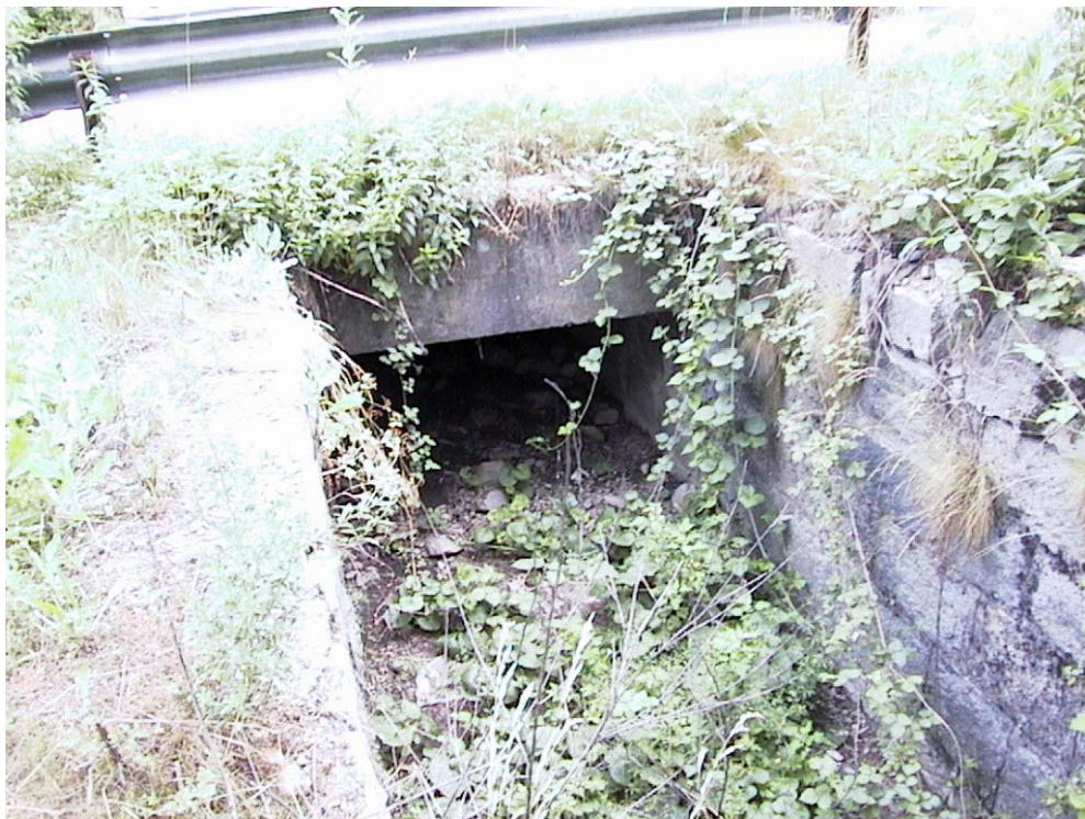
Foto 8: tombotto in corrispondenza dell'attraversamento della SS 42
