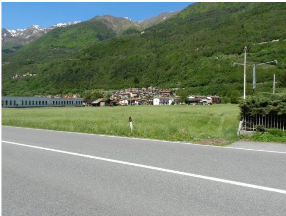
Figura 2: Zona in cui il Varco risulta ancora aperto sulla SS42 nell'area del AT-D10
