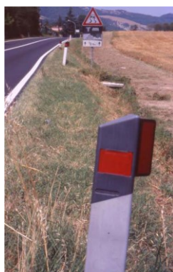
Figura 14: L'uso dei catadiottri si fonda sull'abitudine della fauna a spostarsi prevalentemente dal crepuscolo all'alba, abitudine ampiamente documentata dai dati raccolti nel corso di numerose indagini effettuate sia in Italia, sia all'estero
