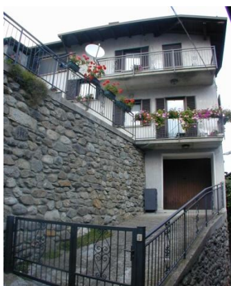
Unità di rilevamento 58a (rif. foto n.51)
