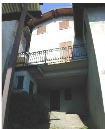
Unità di rilevamento 20a (rif. foto n.15)
