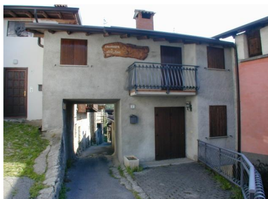
Unità di rilevamento 20a (rif. foto n.16)
