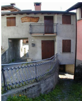
Unità di rilevamento 20a (rif. foto n.17)
