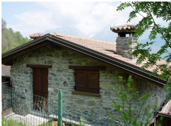
Unità di rilevamento 3A (rif. foto n.1)
