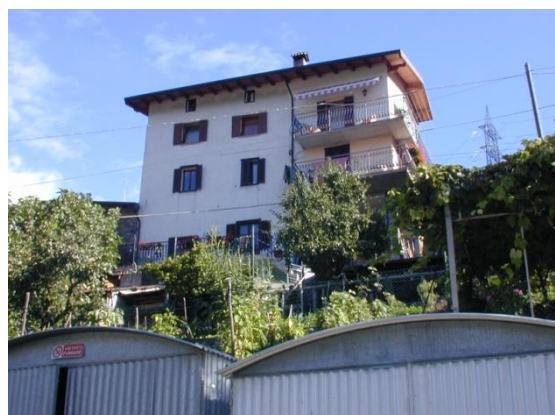
Unità di rilevamento 42 (rif. foto n.20)
