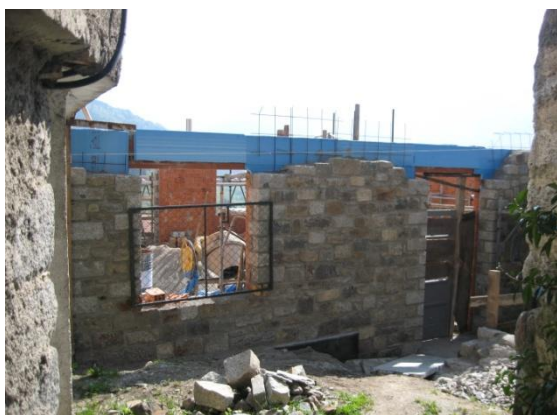
Unità di rilevamento 39 (rif. foto n.19)
