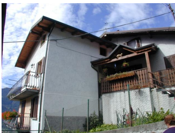
Unità di rilevamento 43 (rif. foto n.23)
