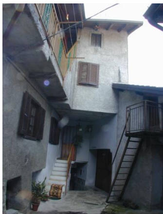
Unità di rilevamento 42 (rif. foto n.21)
