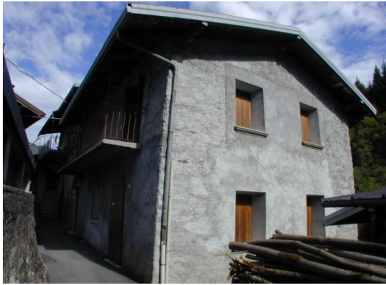
Unità di rilevamento 48 (rif. foto n.25)
