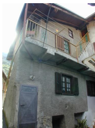
Unità di rilevamento 43 (rif. foto n.24)
