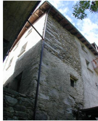
Unità di rilevamento 48 (rif. foto n.26)
