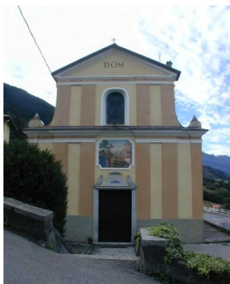
Unità di rilevamento 33 (rif. foto n.1)
