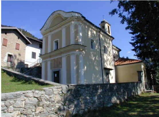
Unità di rilevamento 4a (rif. foto n.1)
