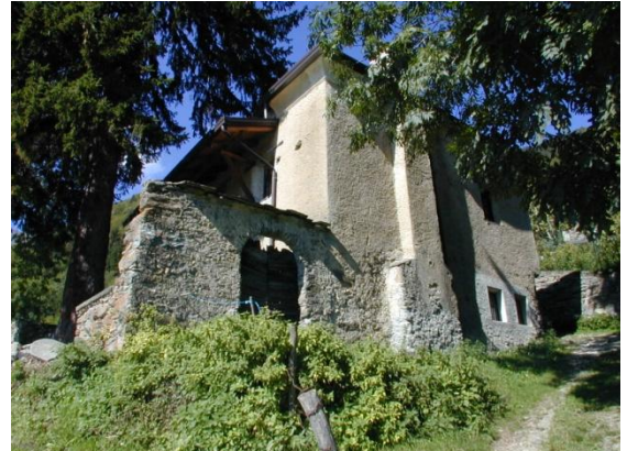
Unità di rilevamento 4a (rif. foto n.2)
