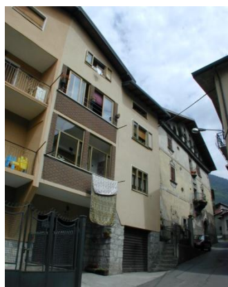
Unità di rilevamento 92a (rif. foto n.76)
