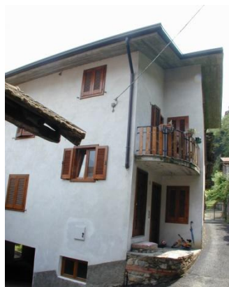
Unità di rilevamento 128a (rif. foto n.94)
