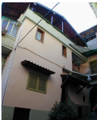
Unità di rilevamento 180a (rif. foto n.133)
