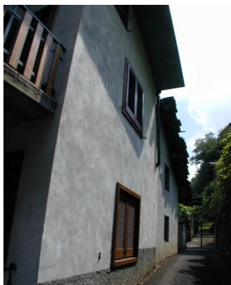
Unità di rilevamento 128a (rif. foto n.93)
