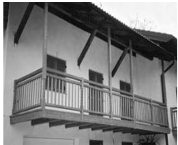
esempio di nuovo balcone
