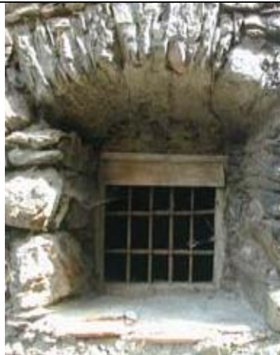
F.3.b – Finestra quadrata con serramento a monobattente in legno e vetro, stipiti in muratura, architrave ad arco a sesto ribassato in pietra, davanzale non aggettante in legno, inferriata interna al vano della finestra in ferro battuto
