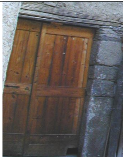
P.1.d – Portale a doppio battente in legno cieco, stipiti in legno, architrave rettilineo in legno
