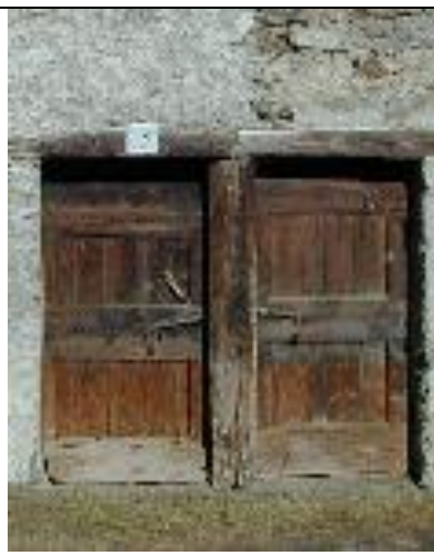
P.1.e – Portale monobattente in legno cieco, stipiti in muratura con montante centrale in legno, architrave rettilineo unico in legno
