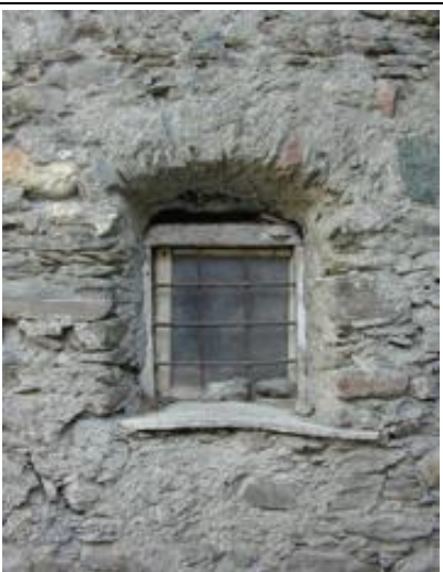
F.3.b – Finestra quadrata con serramento a monobattente in legno e vetro, stipiti in muratura, architrave ad arco a sesto ribassato in pietra, davanzale non aggettante in legno, inferriata interna al vano della finestra in ferro battuto
