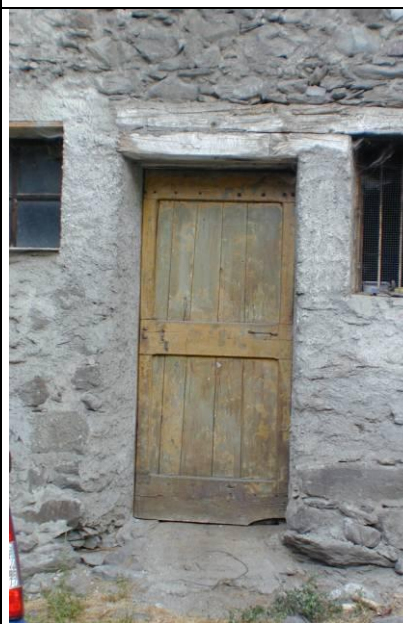
P.1.m – Portale monobattente in legno cieco, stipiti in muratura, architrave rettilineo in legno
