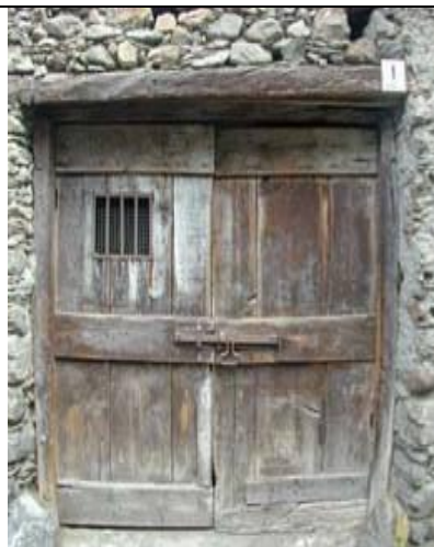
P.1.e – Portale monobattente in legno cieco, stipiti in muratura con montante centrale in legno, architrave rettilineo unico in legno
