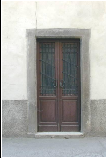
P.1.m – Portale monobattente in legno cieco, stipiti in muratura, architrave rettilineo in legno
