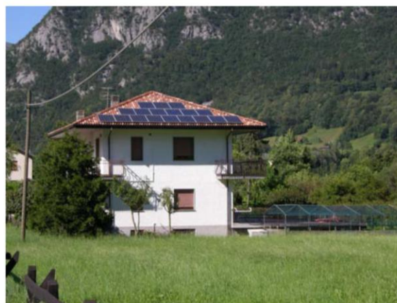
Fig 62. L'inserimento di pannelli fotovoltaici su un'abitazione in un paesaggio di montagna. I pannelli sono posizionati sulla falda più visibile dalla strada per problemi di esposizione. In questo caso è da valutare la possibilità di installare i pannelli a terra. Nel caso di installazione su falda essa dovrà essere particolarmente curata, adottando colori simili a quelli della copertura.
