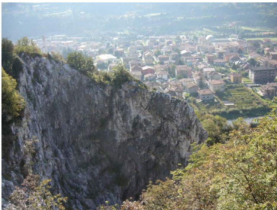
sito estrattivo oggetto di recupero e valorizzazione; sullo sfondo l'abitato di Civate Camuno
