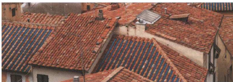
Fig 74. Sistema di integrazione fotovoltaica: si tratta di celle fotovoltaiche inserite tra coppi integrati in una falda prefabbricata. La parziale sostituzione del tetto garantisce un inserimento armonico nel paesaggio, a scapito, tuttavia, della sostituzione della materia preesistente.
