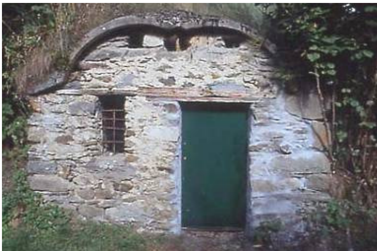
Posto di guardia all'inizio del tratto trincerato.
