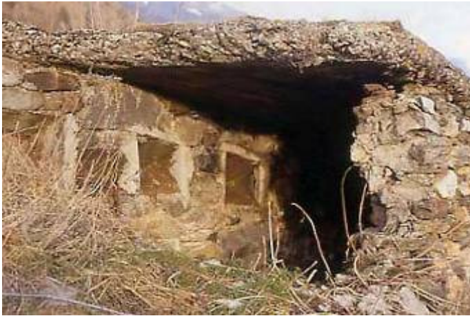
Particolare della trincea con copertura in calcestruzzo al Davenino.
